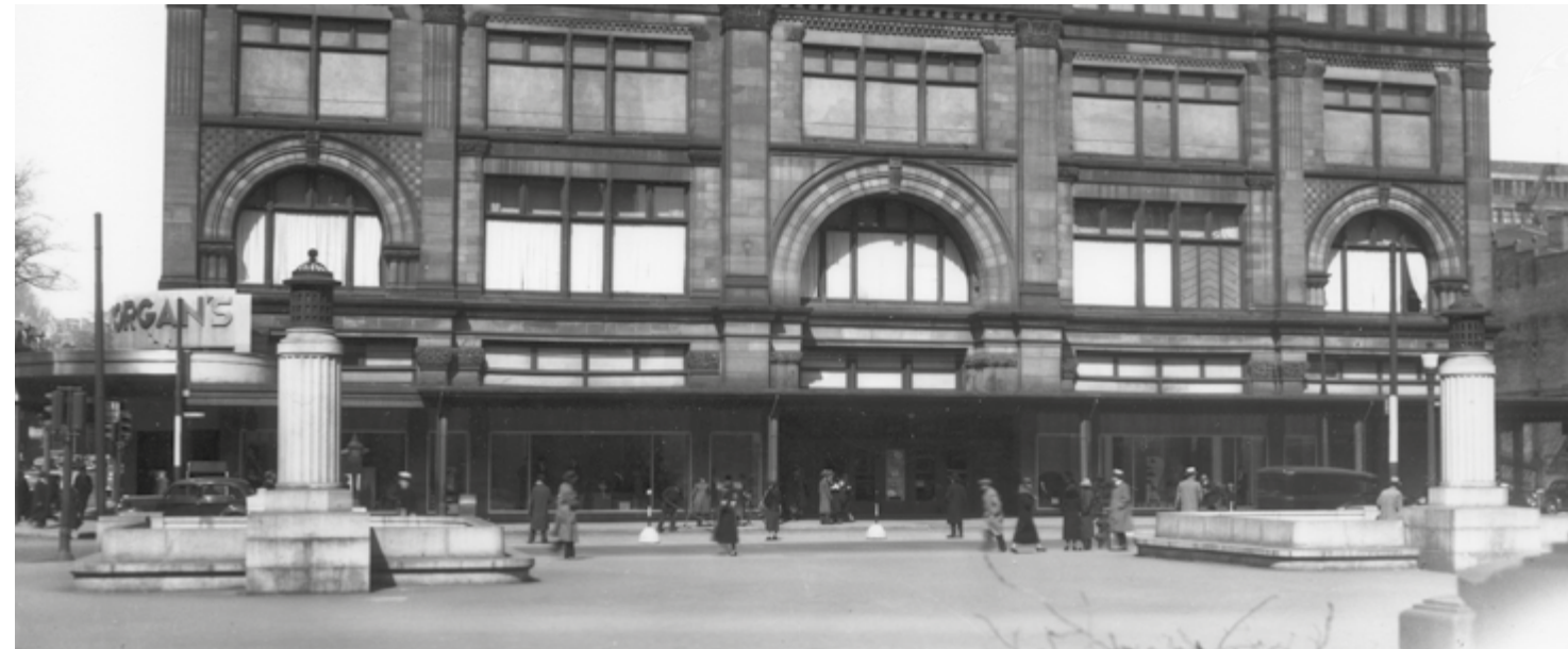
La configuration des vitrines, des entrées et de la marquise de la parcelle A en 1936 (Source: Archives de la Ville de Montréal)
