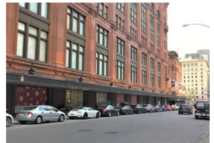
Vue de l'avenue Union depuis la tour KPMG, vers le sud
