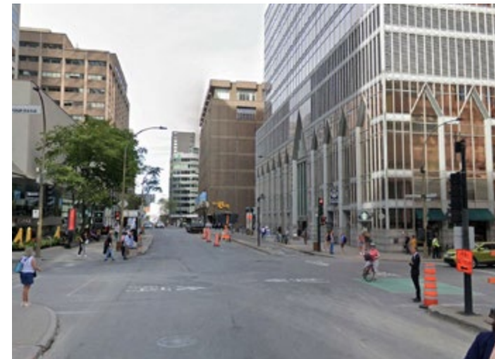
Vue sur le bâtiment de La Baie depuis le boulevard De Maisonneuve, vers l'est
