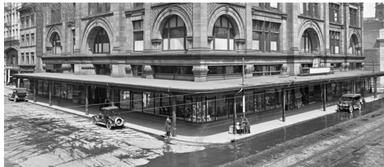
La configuration des vitrines, des entrées et de la marquise de la parcelle A en 1917 (Source: Musée McCord)
