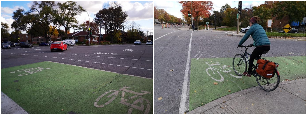
Figures 33 (gauche) et 34 (droite) : Sas vélo à l'intersection de la rue Louvain Est avec la rue St Hubert et Christophe-Colombe respectivement. Prise de vue : P. Viola
