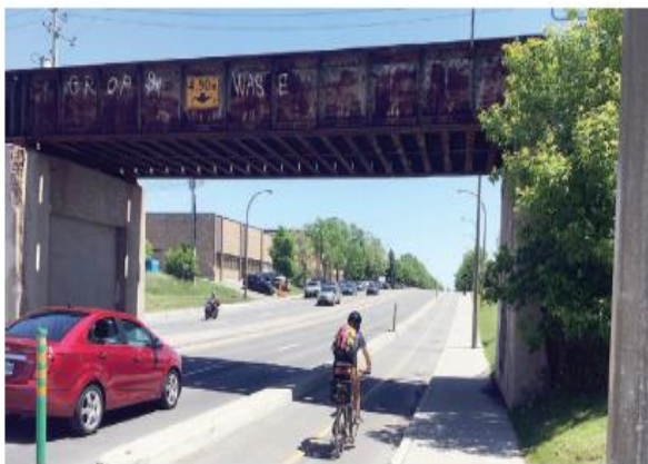
Viaduc avenue Christophe-Colomb
