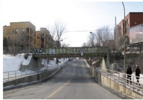
Viaduc rue St-Hubert
