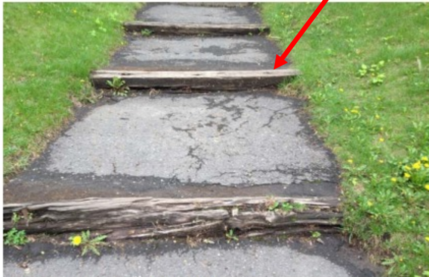
EMMARCHÉMENT D'ASPHALTE ET DE BOIS | SENTIERS AMÉNAGÉS
