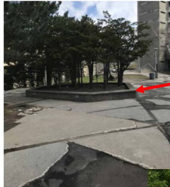
SURFACE DE BÉTON DÉGRADÉE | RÉSIDENCES U de M Plan directeur - OCPM
