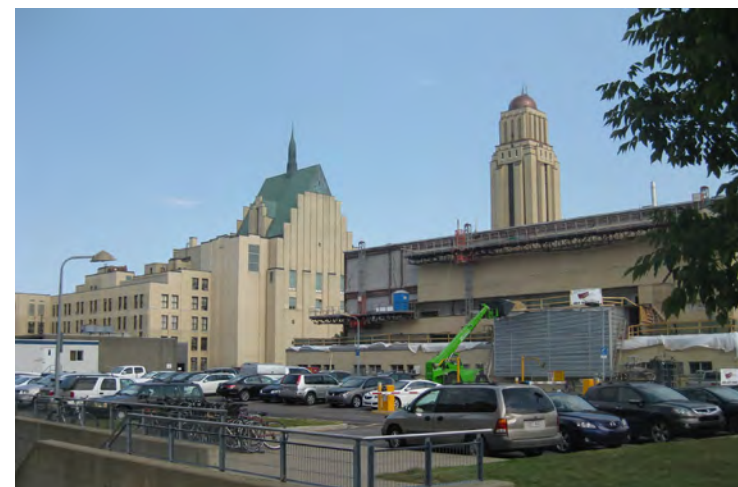
Aménagement du stationnement
