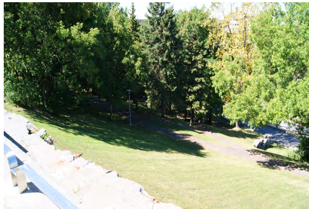
6. Vue vers le mur de soutènement, le talus vert, le sentier piétonnier et le chemin de la Rampe, partie basse.
