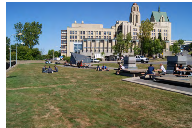
Le toit vert du garage Louis-Colin
