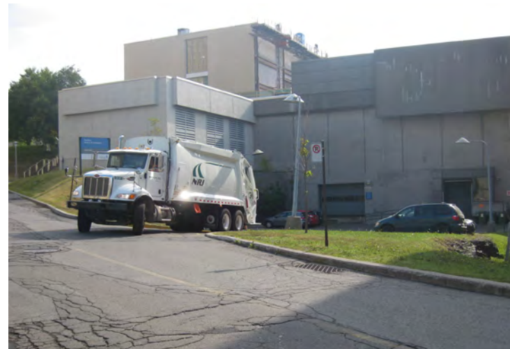
Quai de service, chemin des Services
