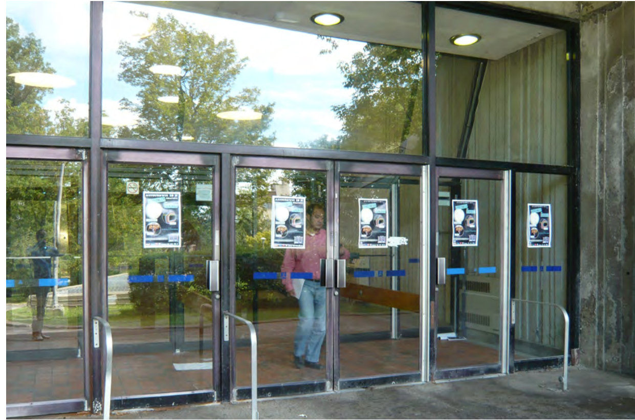
Entrée du tunnel de la rampe mobile
