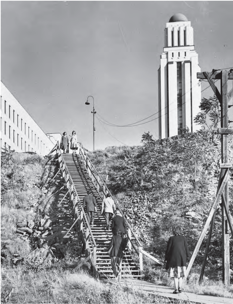
Escalier menant vers le pavillon principal, années 1960
