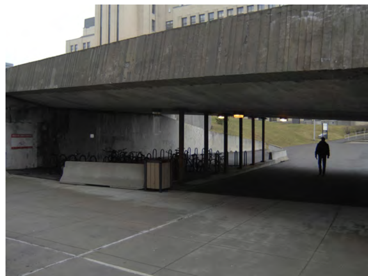
Viaduc du chemin de la Rampe dans la partie nord
