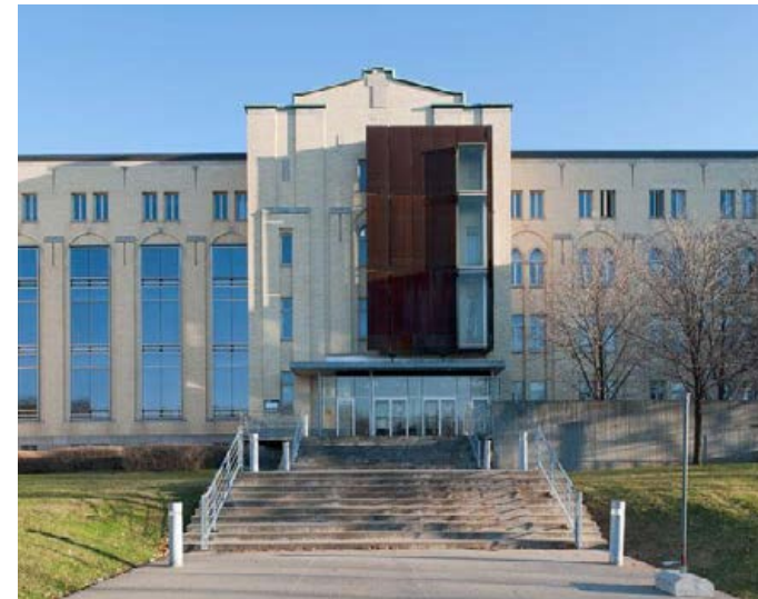
INTERVENTION MODERNE SUR UN ANCIEN BÂTIMENT RELIGIEUX, PAVILLON DE LA FACULTÉ DE L'AMÉNAGEMENT | CRÉDIT : ALAIN LAFOREST
