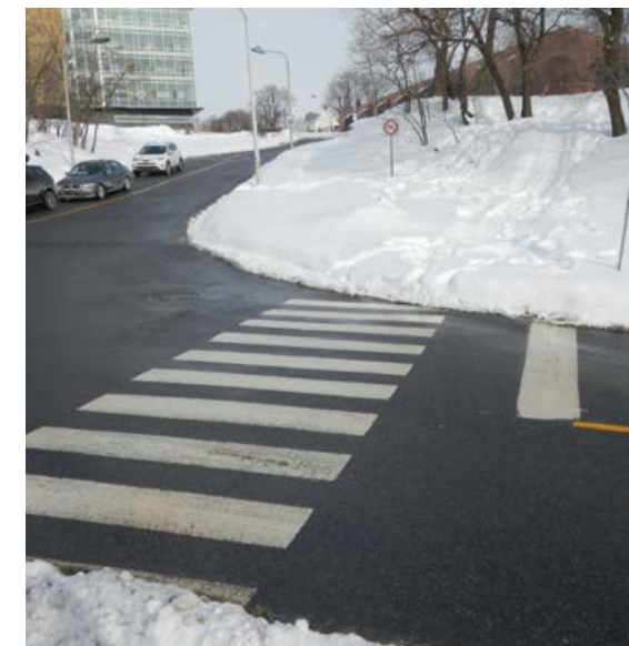
ENTRETIEN DÉFICIENT DES PASSAGES PIÉTONNIERS (LE DÉNEIGEMENT N'EST PAS CONTINU)
