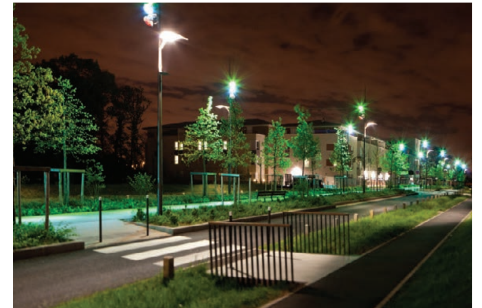
ÉCLAIRAGE DE RUE | FRANCE
