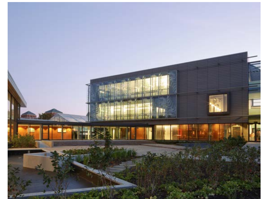
CENTRE DE RECHERCHE EN BIODIVERSITÉ DE L'UNIVERSITÉ DE MONTRÉAL - JARDIN BOTANIQUE DE MONTRÉAL
