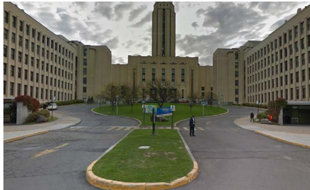
CHAUSSÉE DE BÉTON BITUMINEUX - PAVILLON ROGER-GAUDRY
