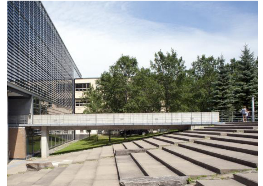
ESPACE DE RASSEMBLEMENT - FACULTÉ DE L'AMÉNAGEMENT (PHOTO : ALAIN LAFOREST, 2011)
