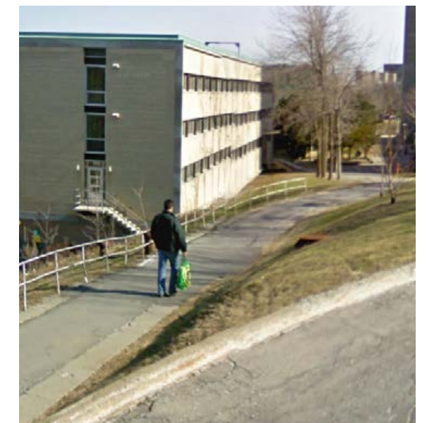
SENTIER DE BÉTON BITUMINEUX - RÉSIDENCES ÉTUDIANTES
