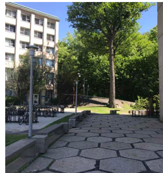
DALLES DE BÉTON - PAVILLON THÉRÈSE-CASGRAIN
