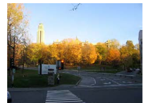
Fig. 11 Vue de l'entrée du chemin de la Rampe Source : Chaire de recherche du Canada en patrimoine bâti, 2008
