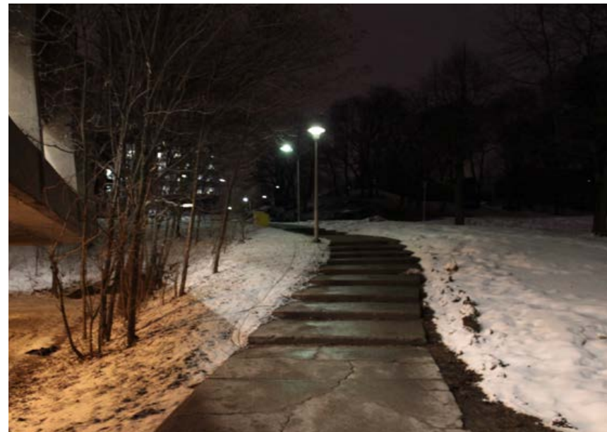
SENTIER PIÉTONNIER, CHEMIN DE LA POLYTECHNIQUE - UNIFORMITÉ DE L'ÉCLAIRAGE
