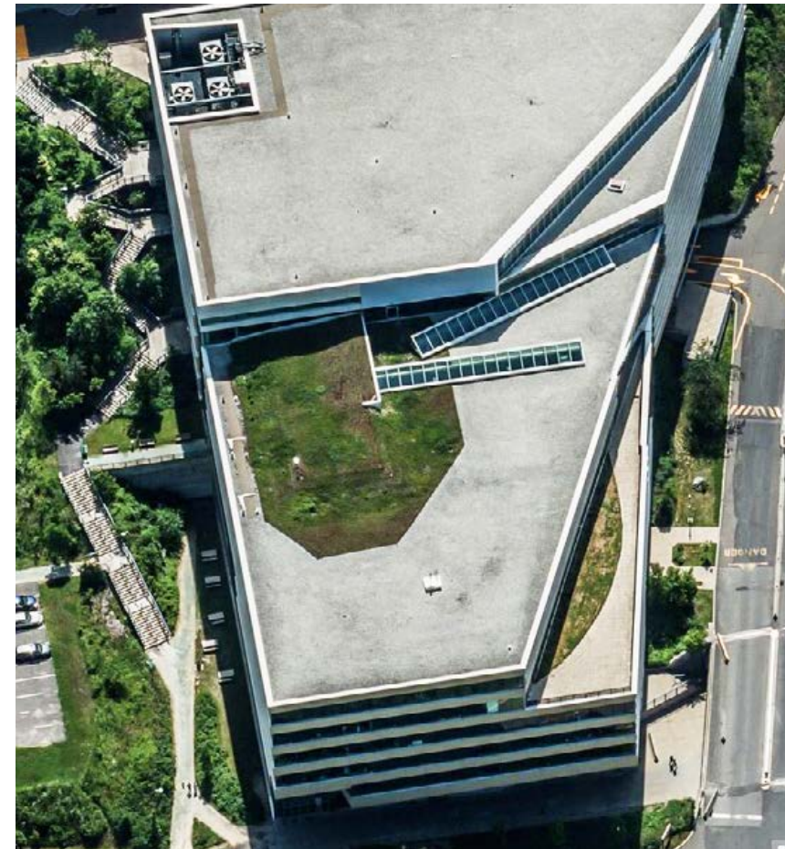
TOIT VERT EXTENSIF DU PAVILLON LASSONDE
