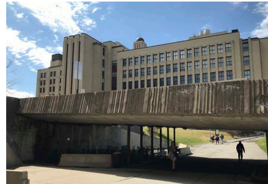
VIADUC PIÉTONNIER DU CHEMIN DE LA RAMPE | UNIVERSITÉ DE MONTRÉAL
