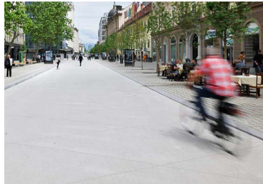
BÉTON COULÉ EN PLACE | BOULEVARD SLOVENSKA, LJUBLJANA, SLOVÉNIE
