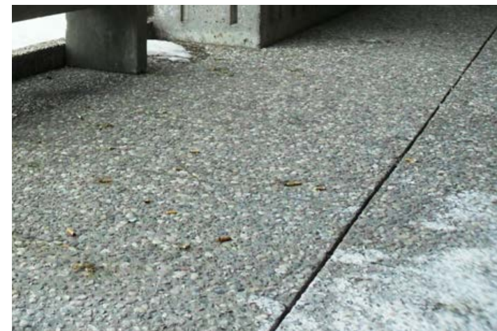
14 MATÉRIAUX DE SURFACE EN DALLES DE BÉTON À AGRÉGATS EXPOSÉS
