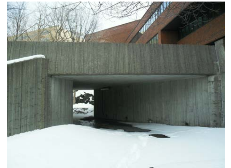
7 VIADUC EN BÉTON STRIÉ
