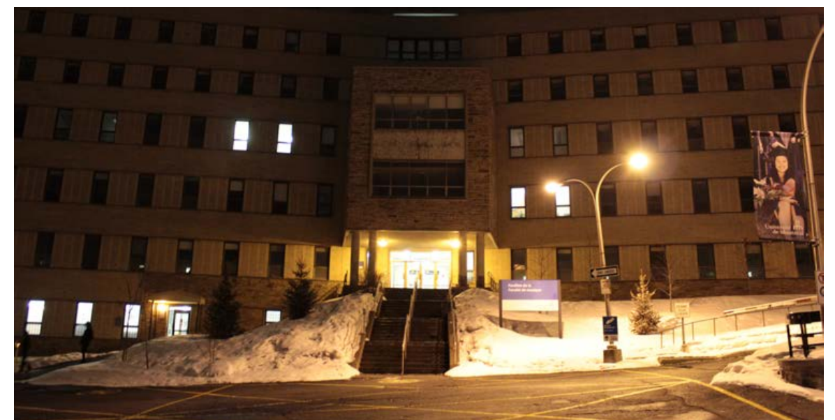
PAVILLON VINCENT D'INDY - ÉCLAIRAGE CONTRIBUANT À L'ISOLEMENT DU PAVILLON
