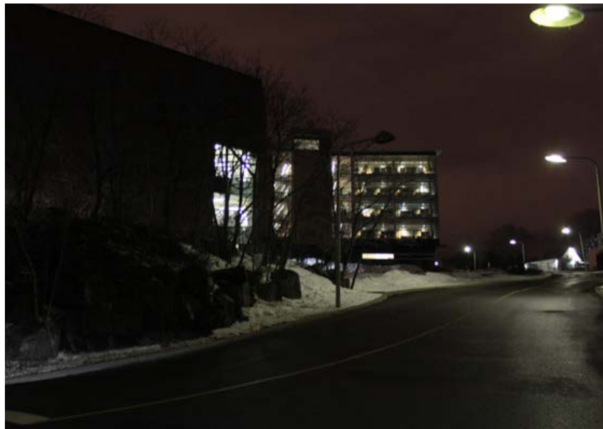
CROISEMENT, CHEMIN DE LA POLYTECHNIQUE - LUMINAIRES ÉTEINTS
