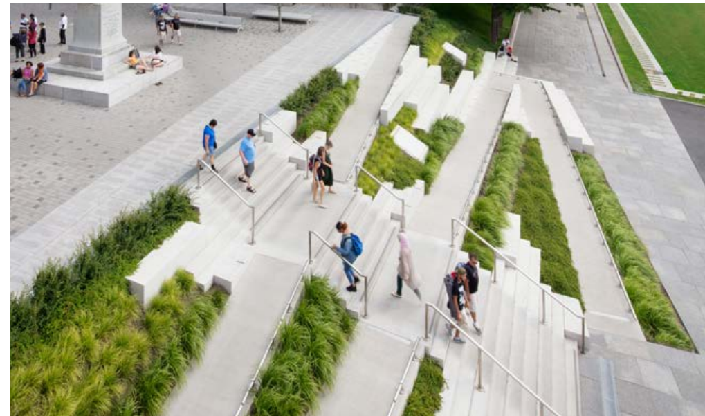
RAMPE D'ACCÈS POUR PERSONNES À MOBILITÉ RÉDUITE | PLACE VAUQUELIN, MONTRÉAL
