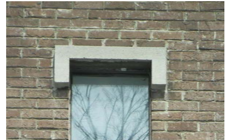
11 LINTEAU DES FENÊTRES
