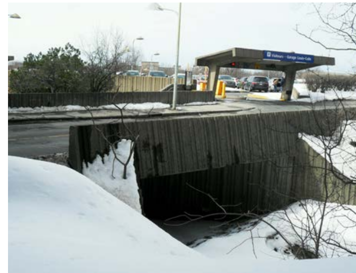
7 VIADUC EN BÉTON STRIÉ
