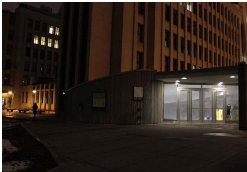
ÉDICULE DE L'ESCALIER MÉCANIQUE INTÉRIEUR - BÂTIMENT PEU VISIBLE
