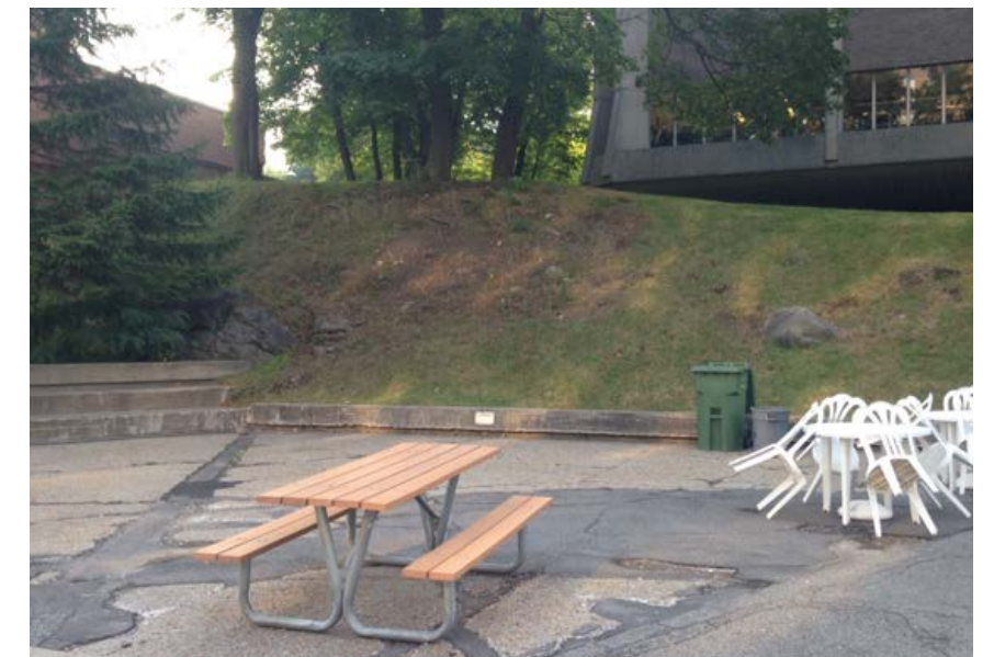
RAPIÉÇAGE DE BÉTON BITUMINEUX - PLACE DE LA LAURENTIENNE
