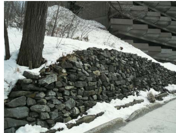
7 MURS DE SOUTÈNEMENT EN PIERRE DES CHAMPS
