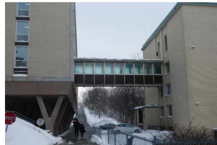
PASSERELLE ENTRE LE PAVILLON DES RÉSIDENCES A ET SES ANNEXES
