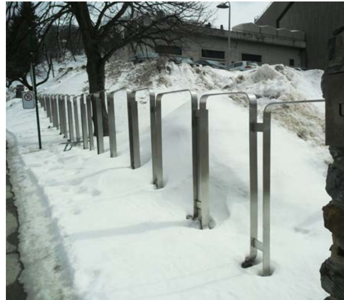
6 CLÔTURE EN ACIER
