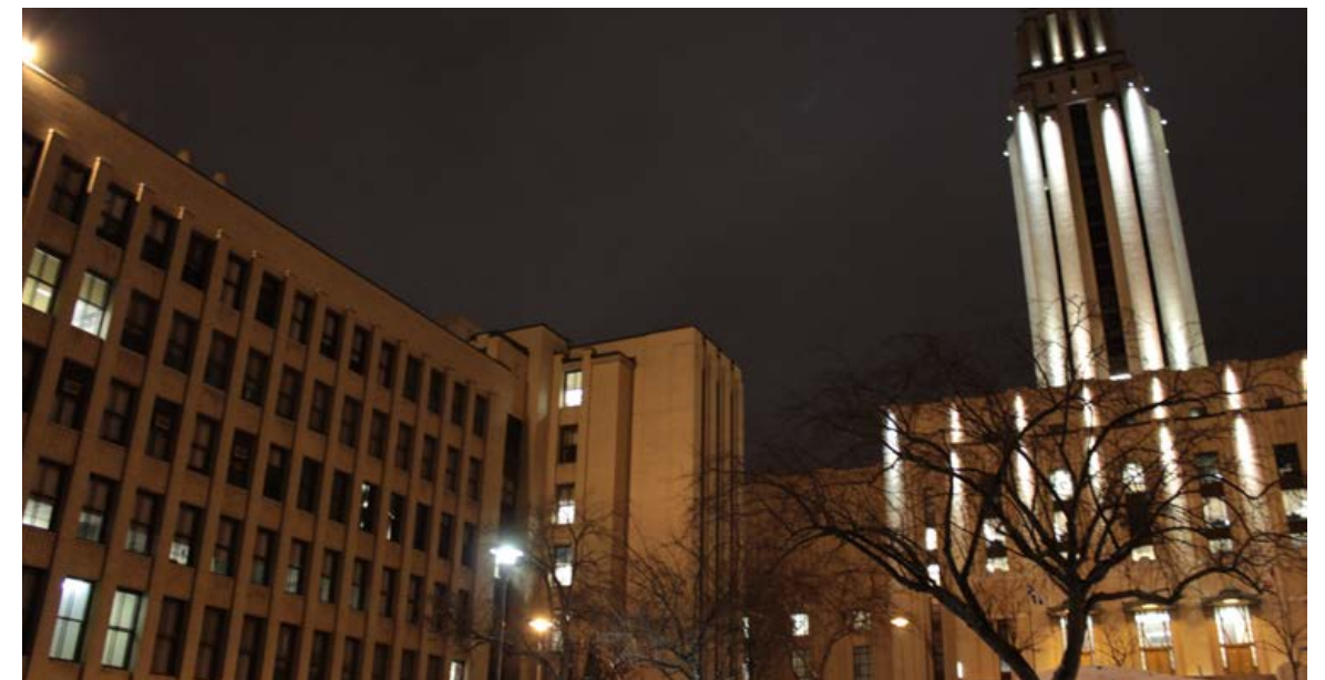
PAVILLON ROGER-GAUDRY - MANQUE DE LIEN ENTRE LA TOUR ET L'ENSEMBLE ARCHITECTURAL
