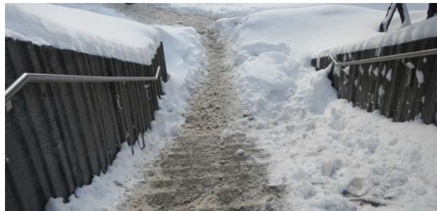
ESCALIER MAL DÉNEIGÉ EN PÉRIODE HIVERNALE
