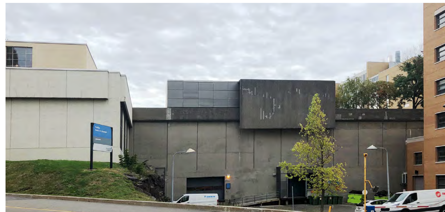
VUE B : DEPUIS LE CHEMIN DES SERVICES, VERS LE HAUT DE L'ESCARPEMENT
