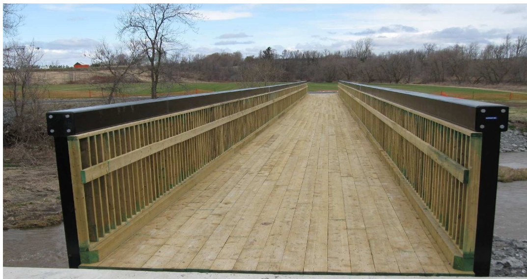
Passerelle Crédit photo Gelco construction
