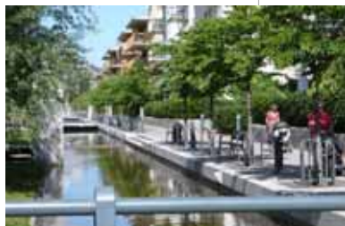
93 | SICKLA KAJ (CANAL)
