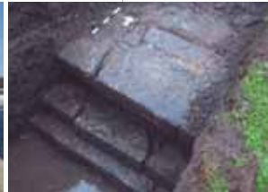
47 | SEGMENT DU MUR NORD DU BASSIN 4
