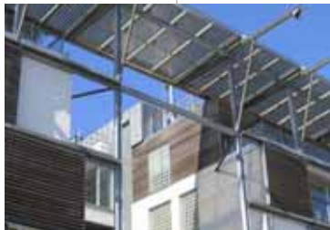
197 | PANNEAUX SOLAIRES, Bc01, MALMO
