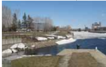
46 | REMBLAI DU BASSIN 4
