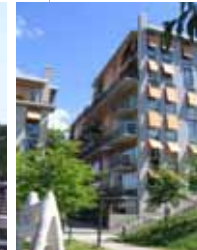
71 | IMMEUBLE, HAMMARBY SJÖSTAD
