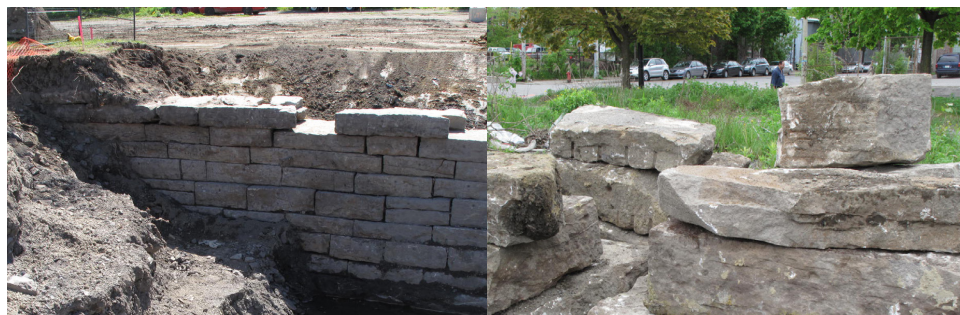
Mur ouest du bassin 3 sous l'emprise de la future rue Basin. Ce mur a été démantelé pour le passage des utilités publiques et les pierres ont été récupérées.
