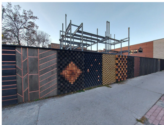
Palissade chantier élégante sur l'avenue du Mont-Royal conçue par des artistes et designers locaux Crédit photo : En temps et lieu (2020)
