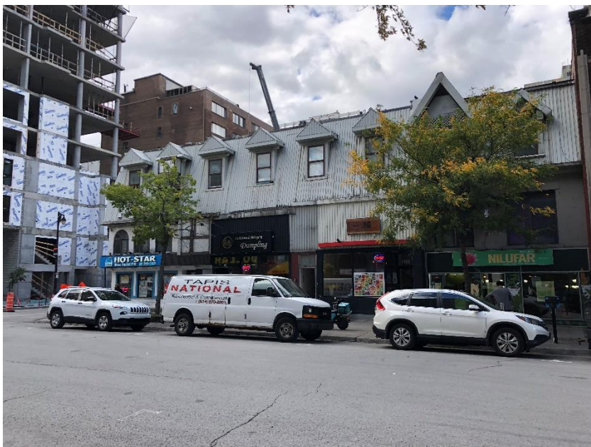
Côté nord de la rue Sainte-Catherine Ouest, entre rue Saint-Marc et rue Towers (à côté du projet d'aménagement Gabriel)
