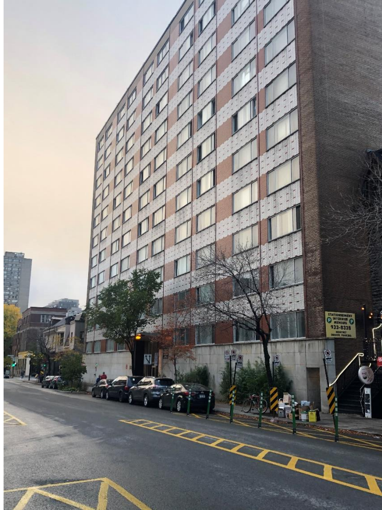
Côté ouest de la rue Saint-Mathieu, entre rue Sainte-Catherine Ouest et boulevard de Maisonneuve Ouest
