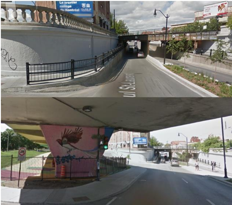
Figure 4-13 Passage inférieur rue Saint-Laurent, Montréal (identité, embellissement)
