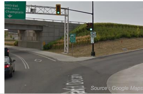
Boulevard Décarie, au nord de l'échangeur Traverses piétonnes non signalisées
