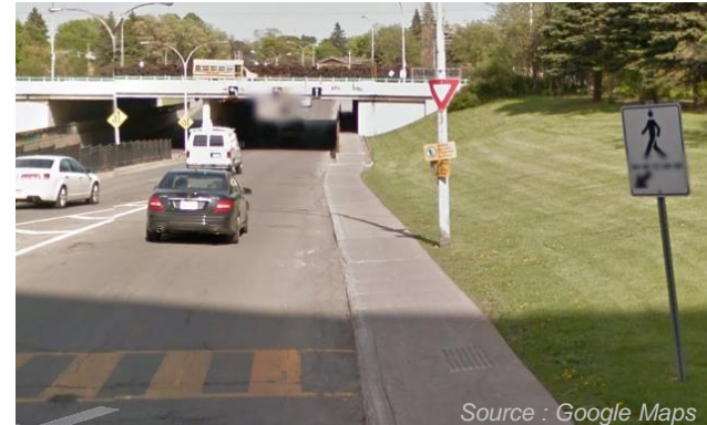
Boulevard Cavendish Passage piéton
