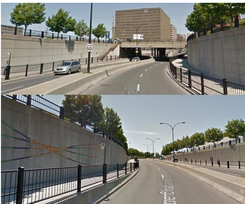
Figure 4-14 Passage inférieur Chabanel, Montréal (identité, embellissement, agrandissement du trottoir, séparation physique continue de la chaussée)
