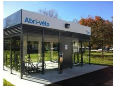
Abri -vélo sécurisé Station Lionel-Groulx
