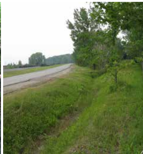
fossé en bordure de la cour de triage Saint-Luc
