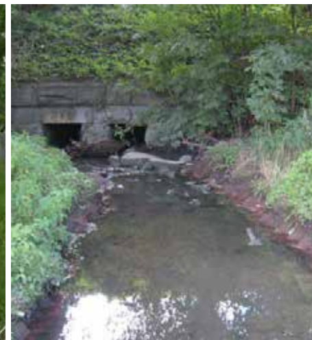
Golf Meadowbrook - raccordement du fossé au collecteur
