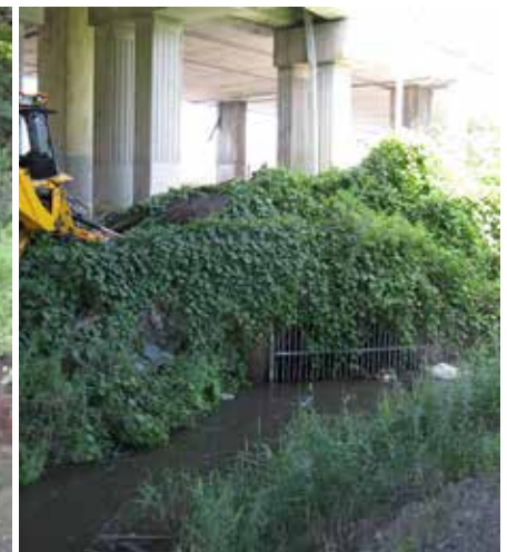
Raccordement du fossé du Gouvernement au collecteur
