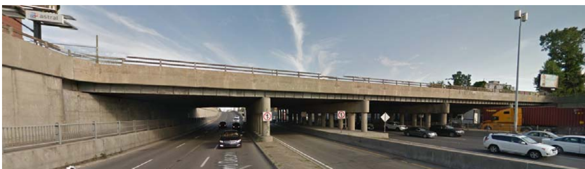
Figure 6-1 Pont ferroviaire du CP
