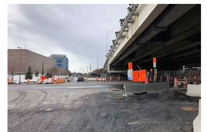
Bretelle d'accès A-15 sud
