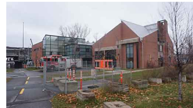
Caserne de pompiers
