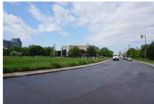
État actuel de la rue Levert
