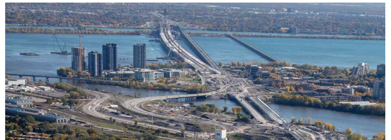
Chantier pour le nouveau pont Samuel-De Champlain et vue sur une partie de l'autoroute Bonaventure (Source : Infrastructure Canada)
