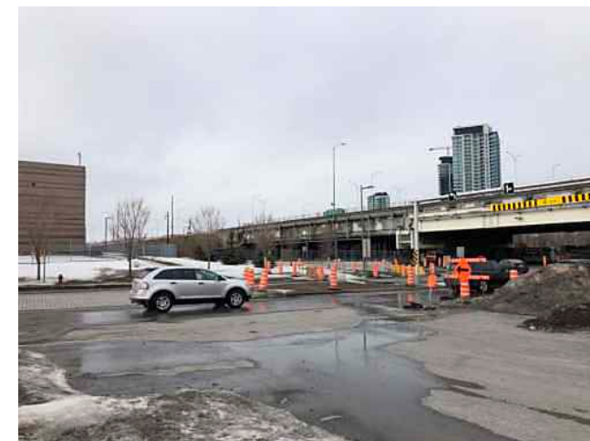
Nombreux chantiers dans le secteur
