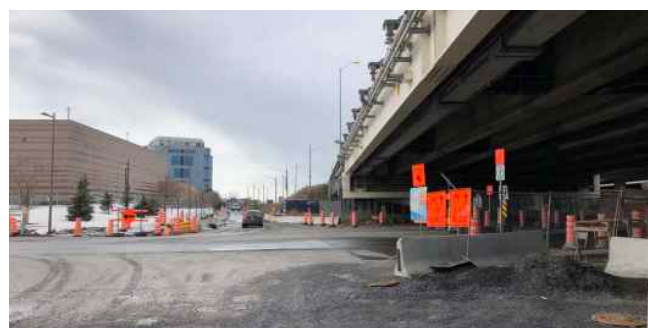
Bretelle d'autoroute A-15 sud à transformer
