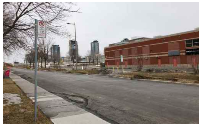
Etat actuel de la partie ouest de la boucle place du Commerce
