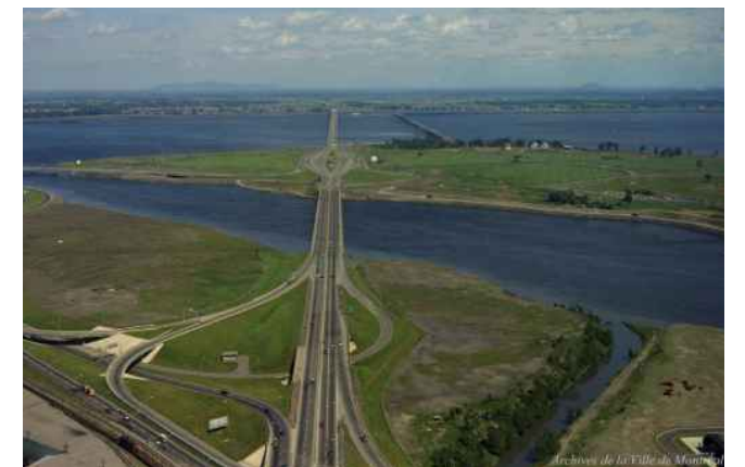
Construction du pont Champlain dans les années 1960
