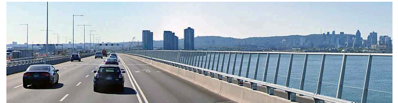
Vue existante à partir du pont Samuel-De Champlain, avec également le mont Royal et le centre-ville en perspective (Source : Google, 2020)
