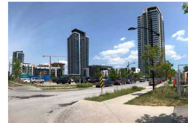
Construction de tours d'habitation dans le quartier Pointe-Nord
