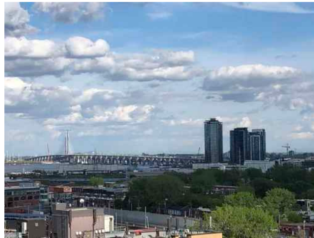
Les tours Evolo du quartier Pointe-Nord et le nouveau pont
