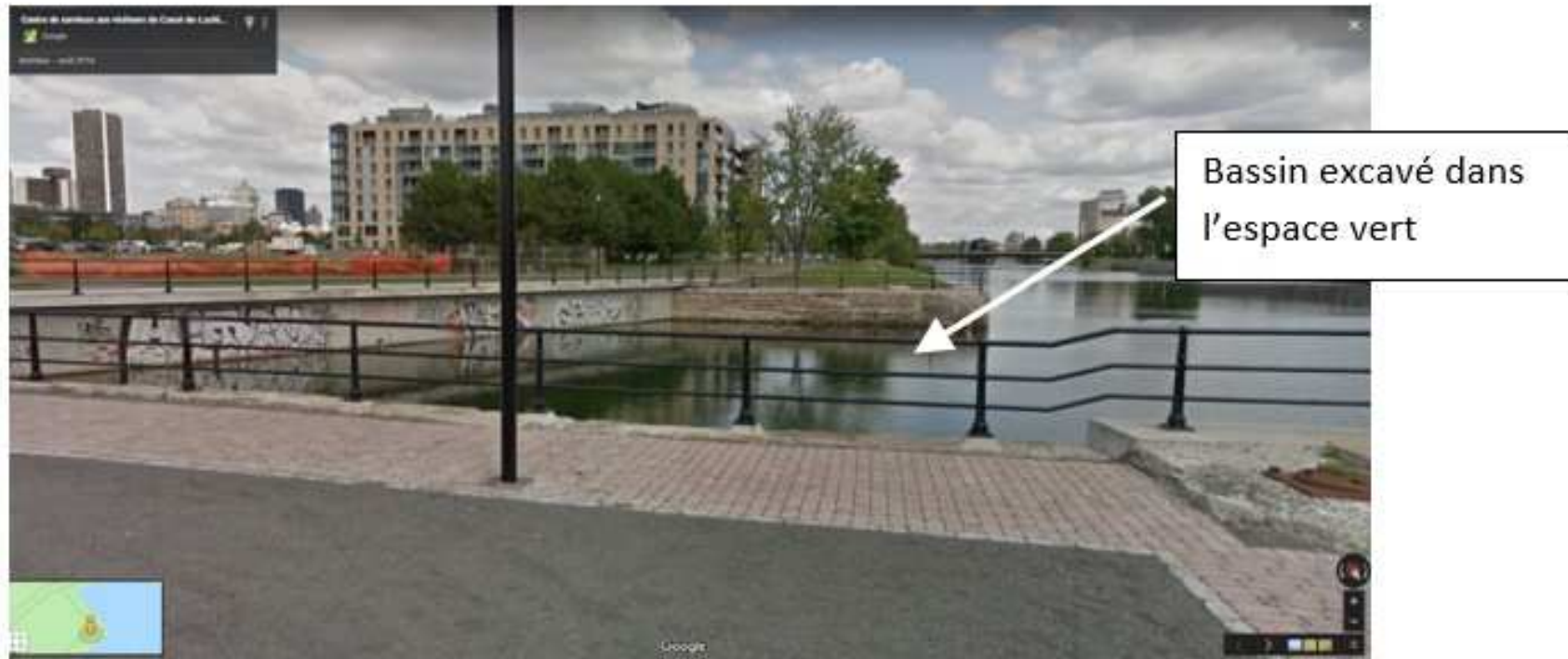
Bassin excavée dans un espace vert - Bassins du Nouveau Havre
