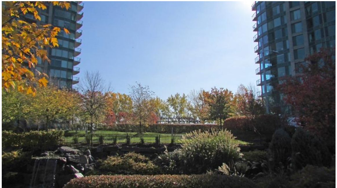
Distance de 43 mètres entre les deux tours Vistal
