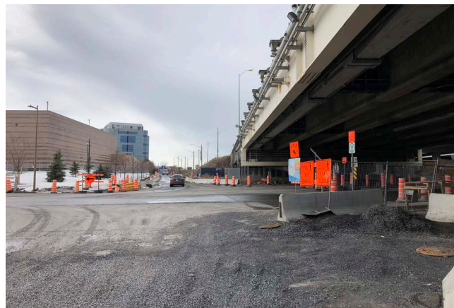
Bretelle d'accès A-15 sud
