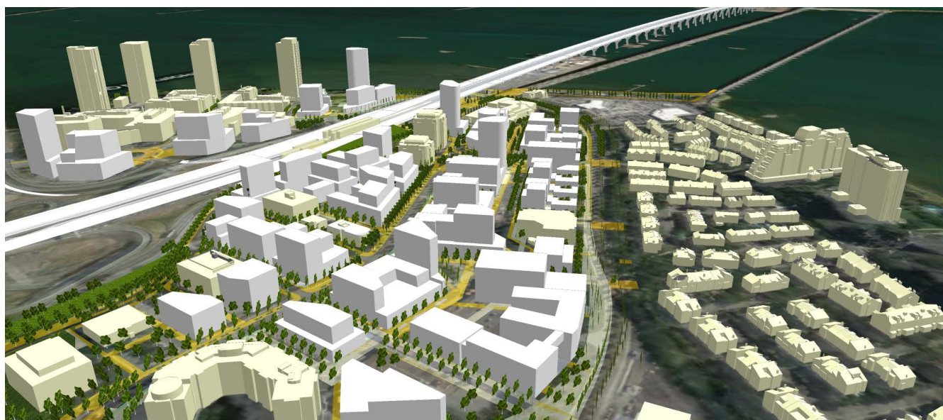
Vue aérienne en direction est illustrant les interventions, dont la gradation des gabarits par rapport à l'autoroute
