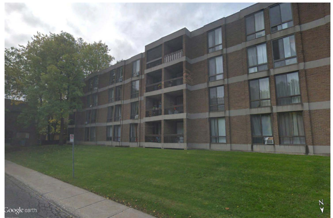
Immeuble résidentiel au centre de l'île (Source : Google, 2019)
