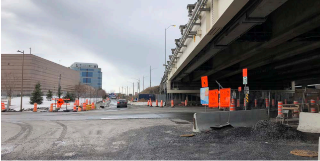
Bretelle d'autoroute A-15 sud à transformer
