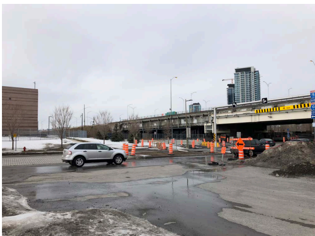
Nombreux chantiers dans le secteur
