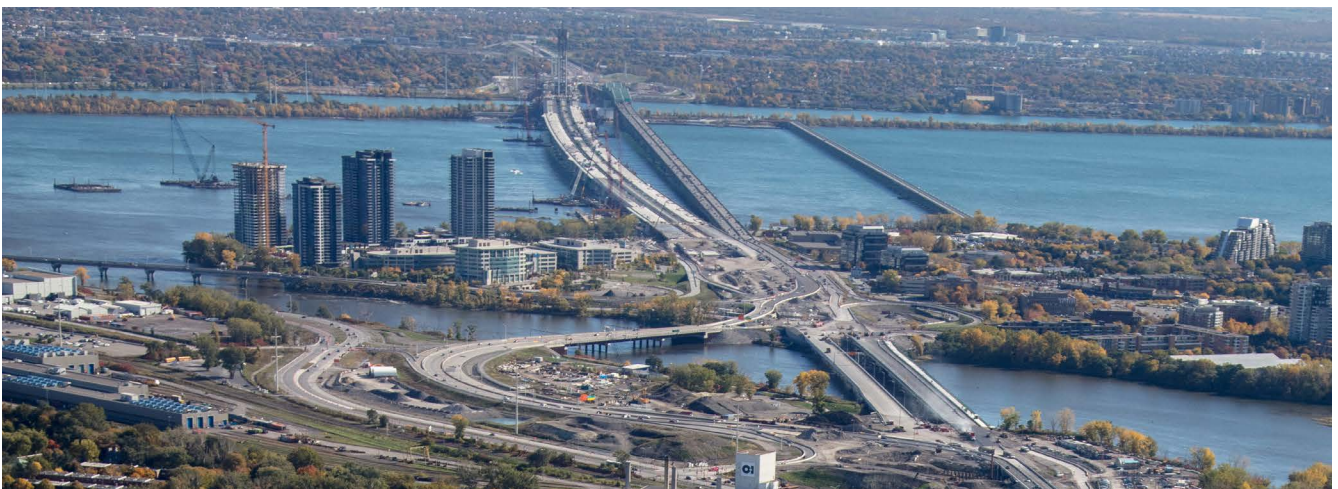
Chantier pour le nouveau pont Samuel-De Champlain et vue sur une partie de l'autoroute Bonaventure (Source : Infrastructure Canada)
