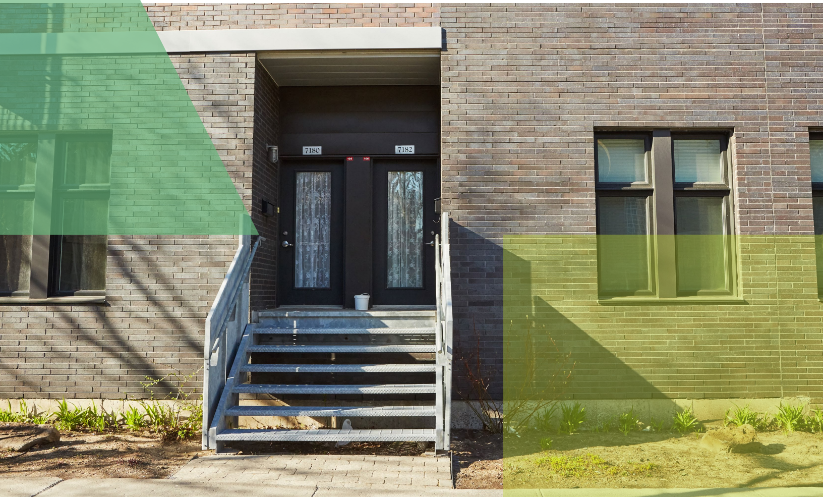
Résidence Alfredo-Gagliardi, rue Berri
