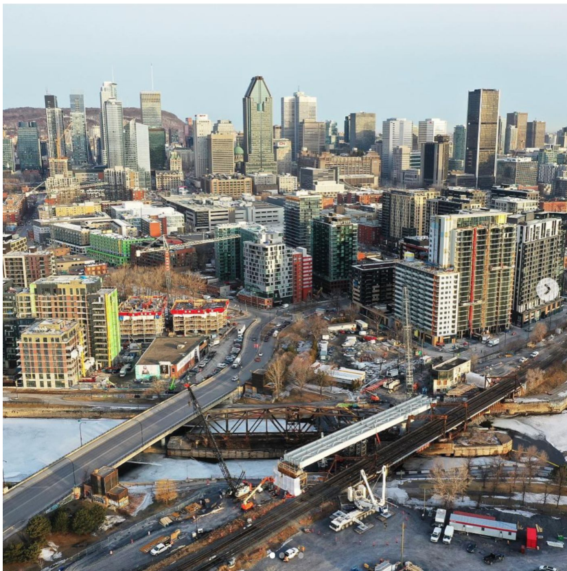
Les piétons, les moins favorisés du secteur Bridge-Bonaventure Source image : REM
