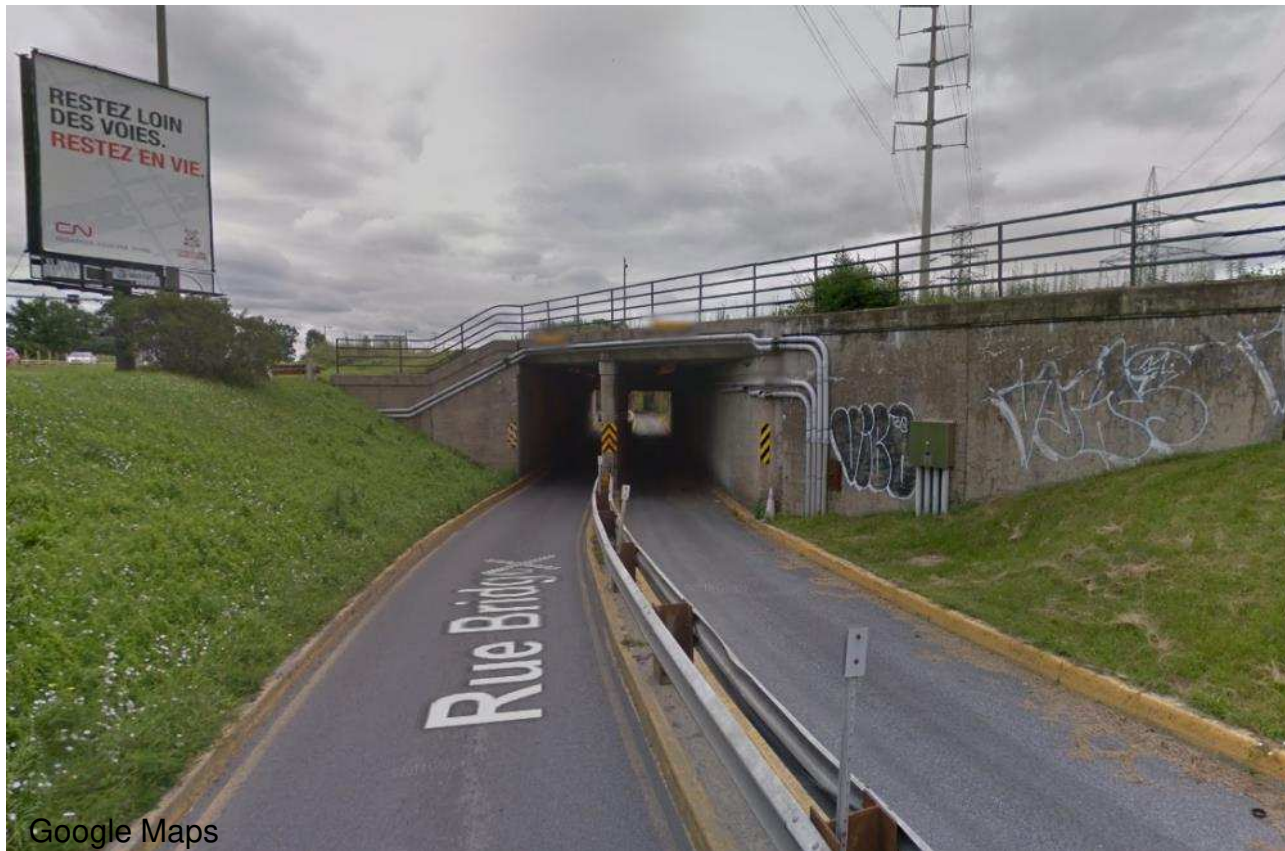
Passage inférieur au pont Victoria
