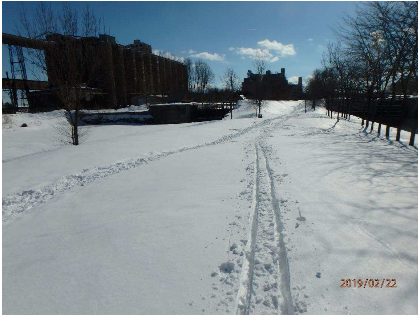
Écluse no 1 et 2, photo: Le skieur urbain
