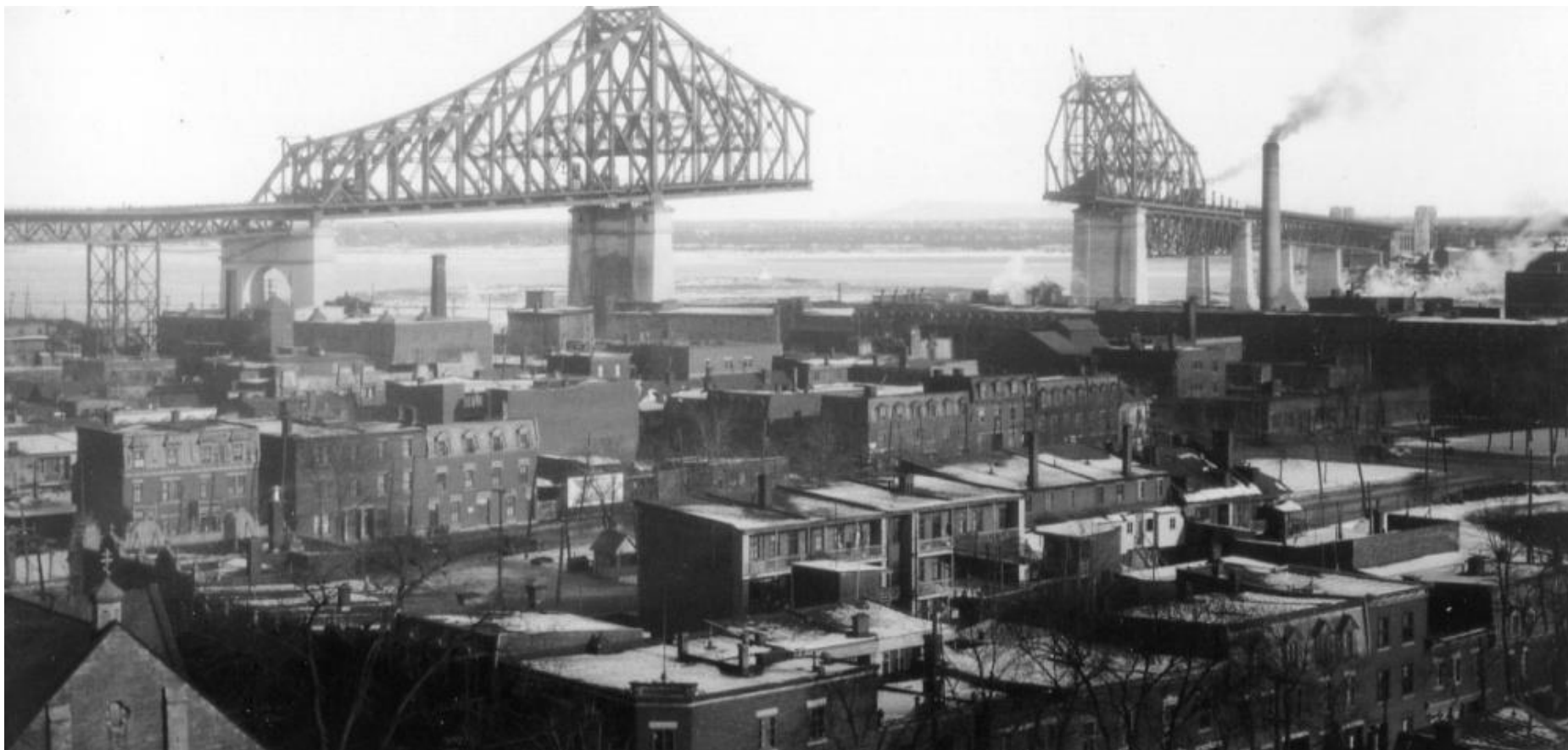
Construction du pont Jacques-Cartier, 1929.
