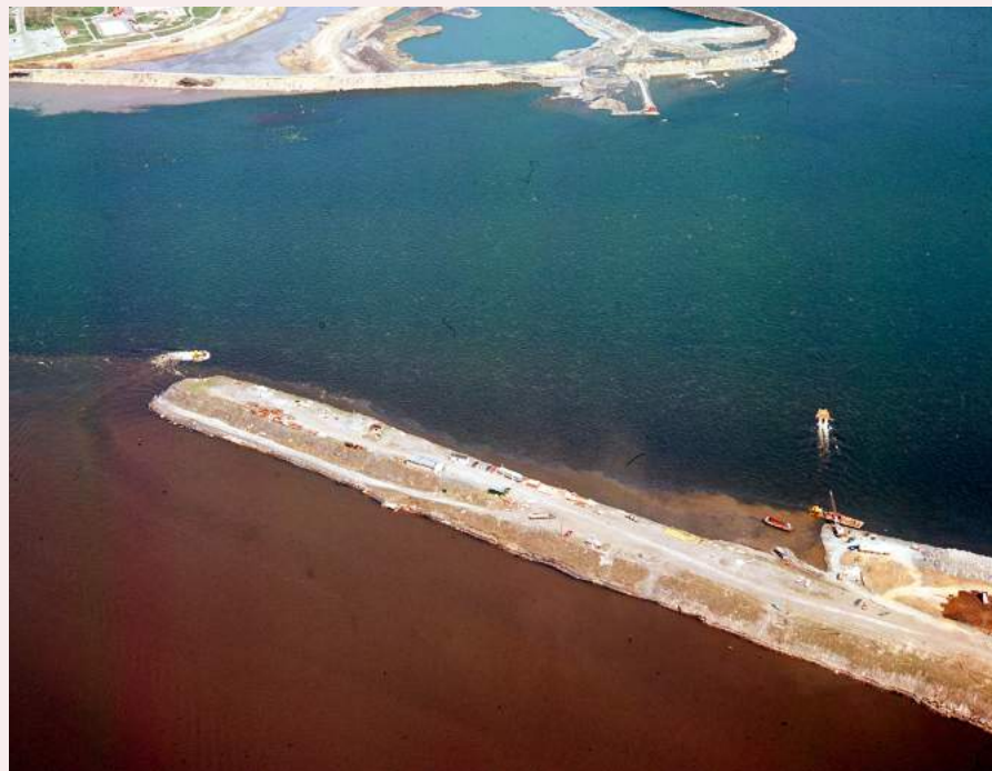
Construction de la pointe de la Cité du Havre, 1964, Archives de la Ville de Montréal, VM94-Ad22-015.
