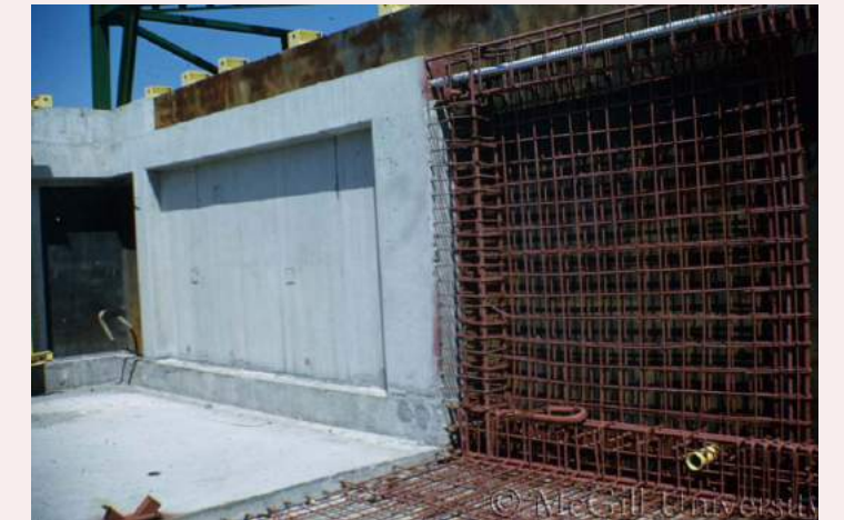
Armature des blocs de béton préfabriqués, 1966-1967, Archives de McGill University.
