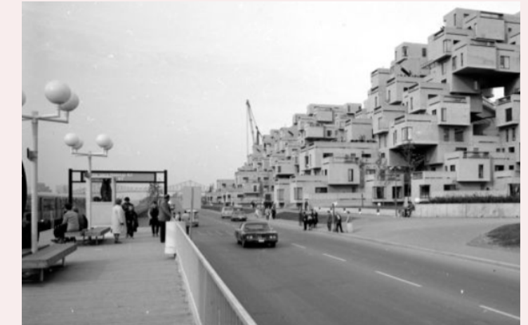
En 1967, l'emprise du chemin Andersen est partagée entre les rails de l'Expo-Express et une chaussée asphaltée, BANQ E6,S7,SS1,D672401-672401.
