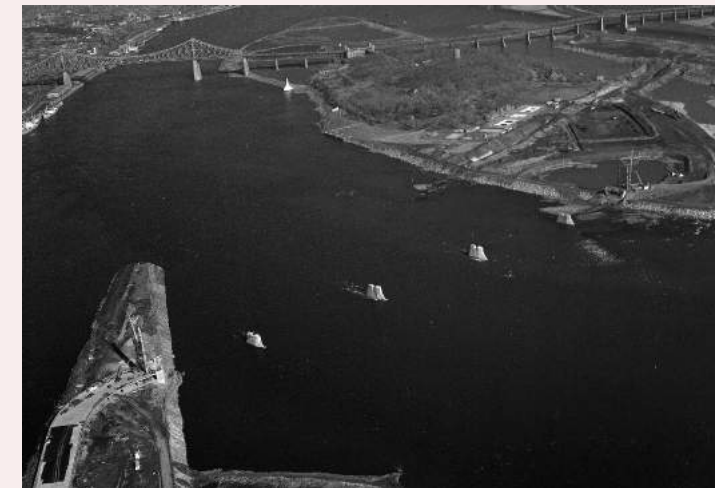
Construction du pont de la Concorde, 1964, Archives de la Ville de Montréal, VM94-EX35-017.
