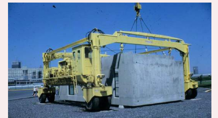
Bloc de béton prêt à être assemblé aux autres unités d'habitation, 1966-1967, Archives de McGill University.
