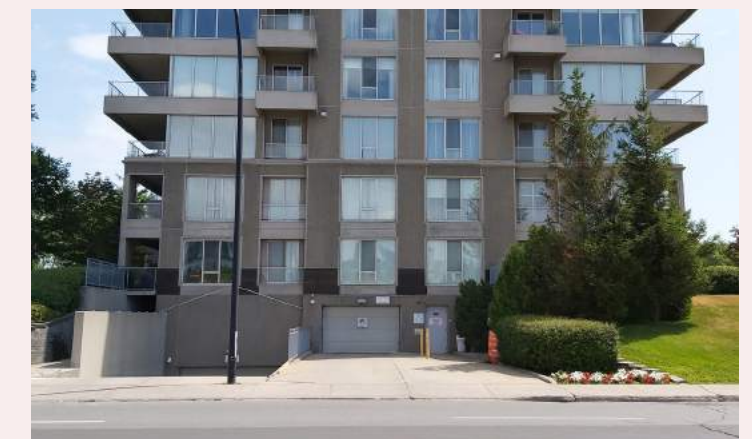
Face ouest du bâtiment qui comprend les entrées de stationnement souterrain, 2019, Ariane Malo-Sauvé.
