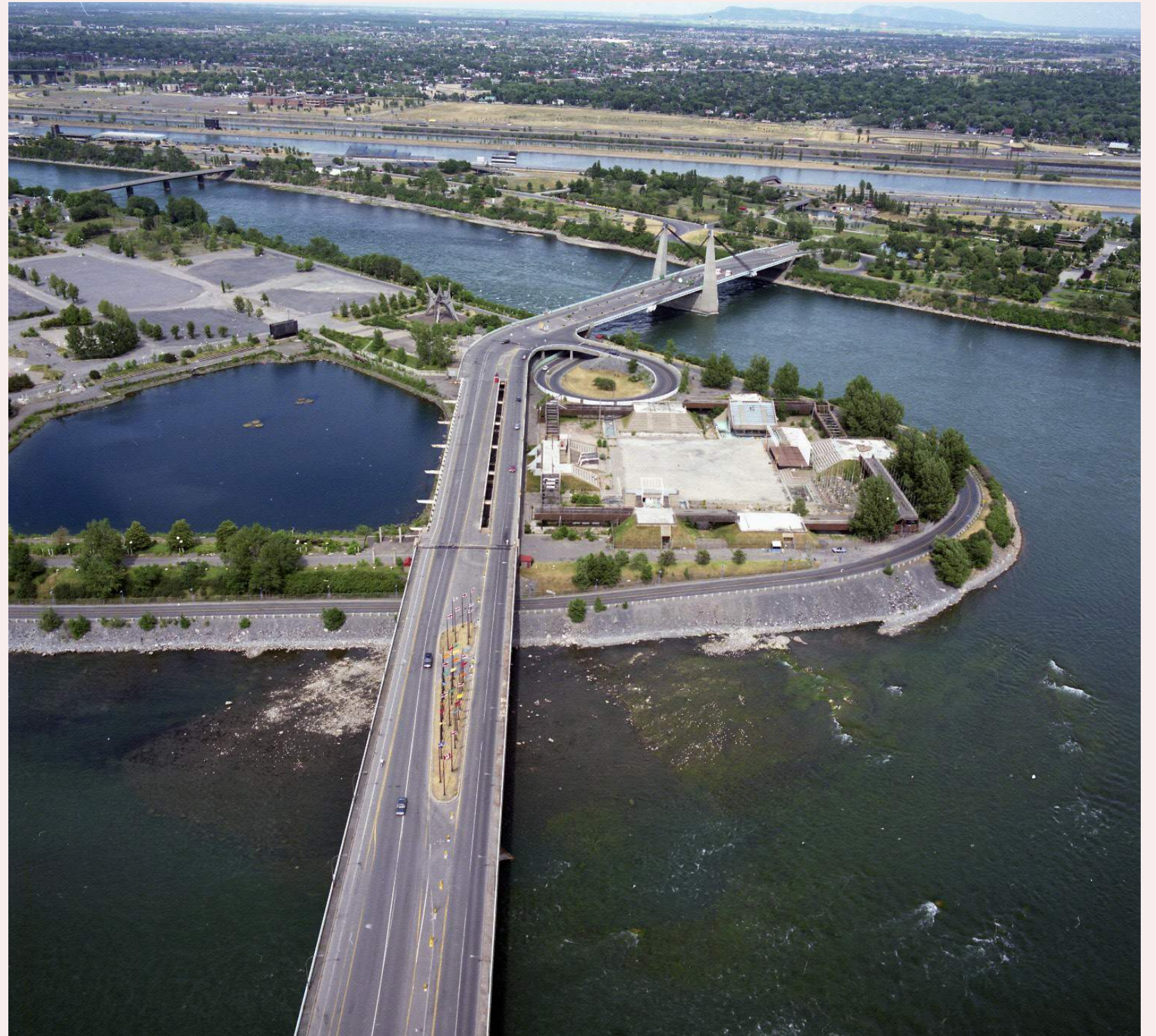
Les rails maintenant retirés, le pont de la Concorde porte des mâts à drapeaux, 1988, Archives de la Ville de Montréal, VM94-B268-060.
