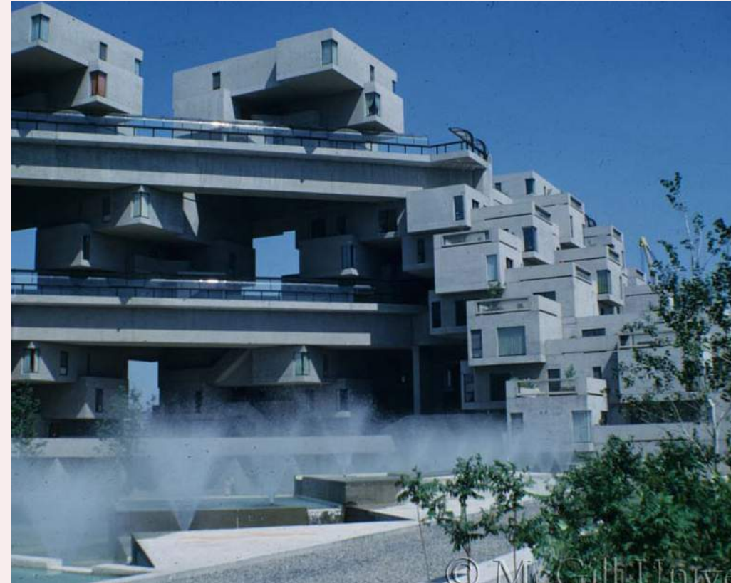
À l'arrière, des bassins en paliers avec fontaines : un système de climatisation naturelle, McGill University.
