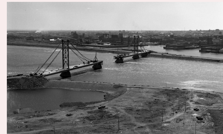
Construction du tablier, vers 1965, Archives de la Ville de Montréal, VM94-B14-001.
