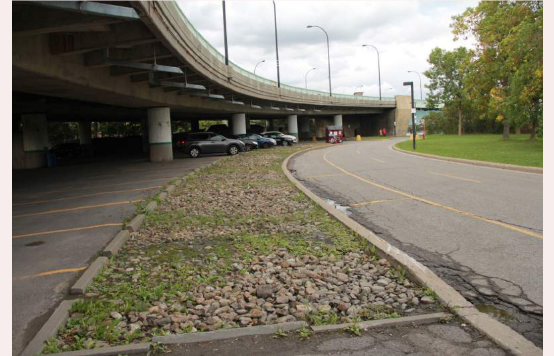
Stationnement sous le tablier du pont, 2019, Ariane Malo-Sauvé.
