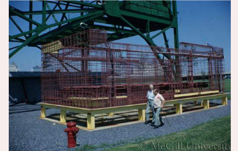
Armature des blocs de béton préfabriqués qui serviront aux appartements d'Habitat 67, 1966-1967, Archives de McGill University.
