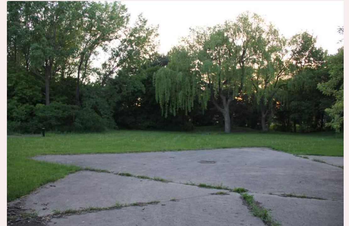
Dalle de béton : vestige du pavillon de l'Hospitalité et du Gaz naturel, 2019, Ariane Malo-Sauvé.
