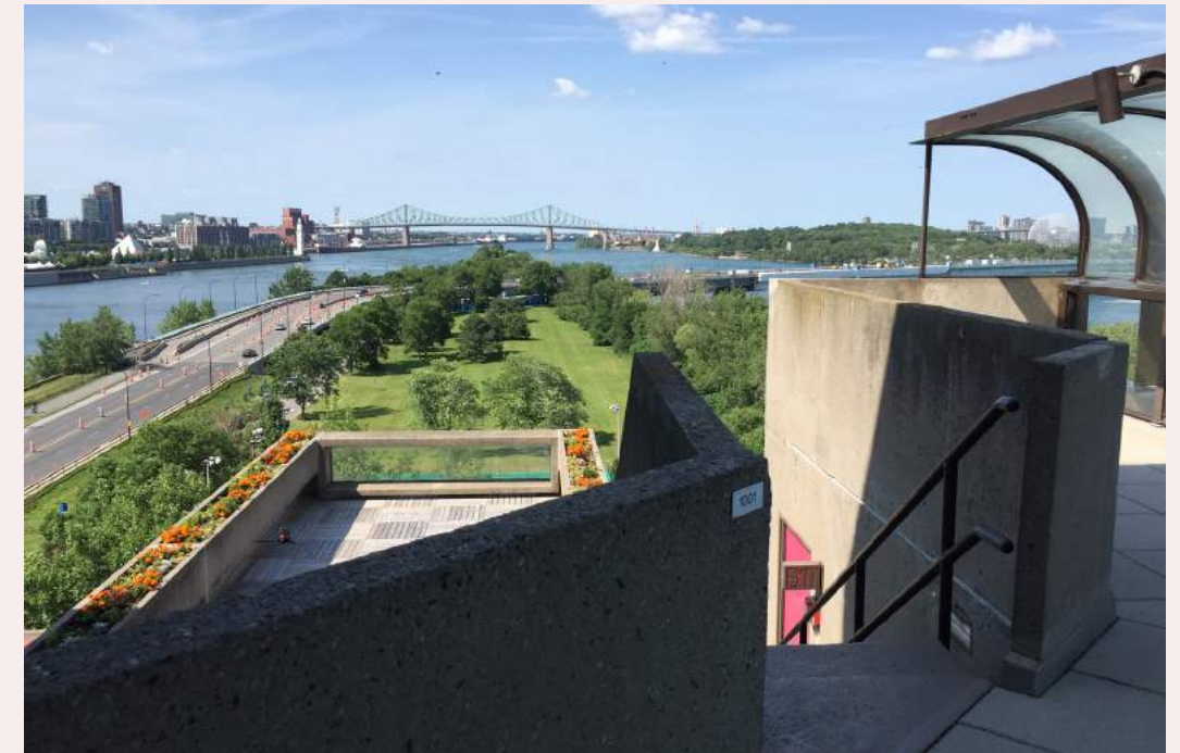
Vue sur la pointe de la Cité du Havre à partir d'une terrasse du complexe, 2019, Guillaume Archambault-Lelièvre.
