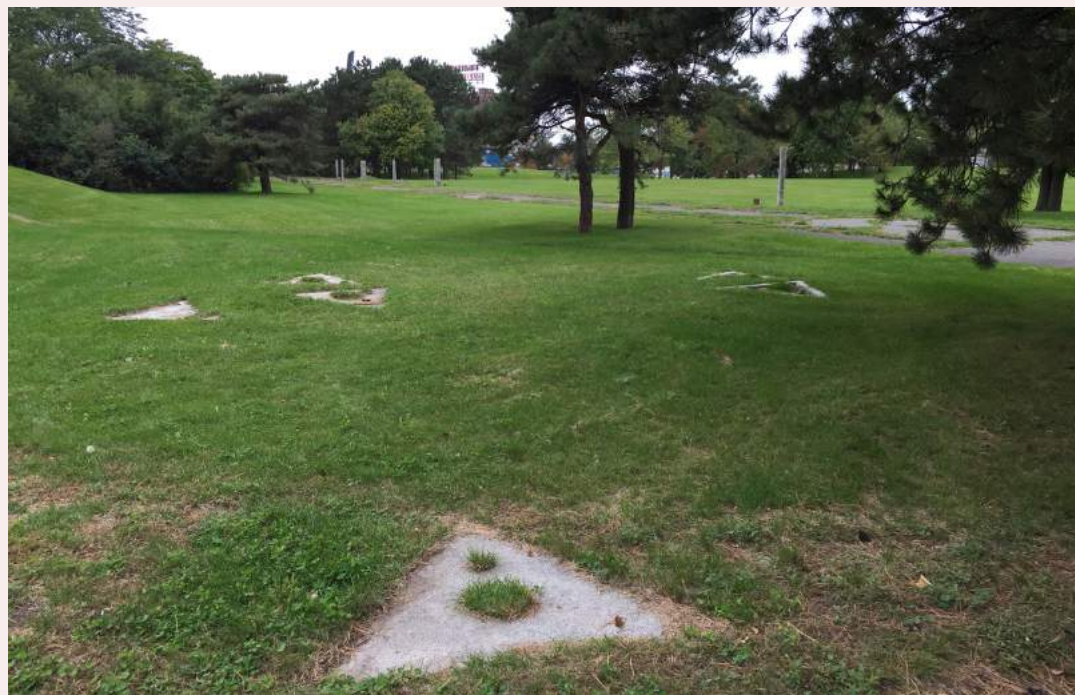
Bases de béton: vestiges de lampadaires, 2019, Ariane Malo-Sauvé.
