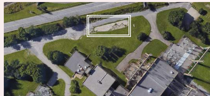
Vue rapprochée du terrain du poste Viger, où l'on observe toujours un vestige du terminus d'autobus de l'Expo, 2019, Google Earth.
