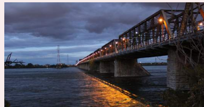
Vue remarquable du pont Victoria, 2019, Ariane Malo-Sauvé.
