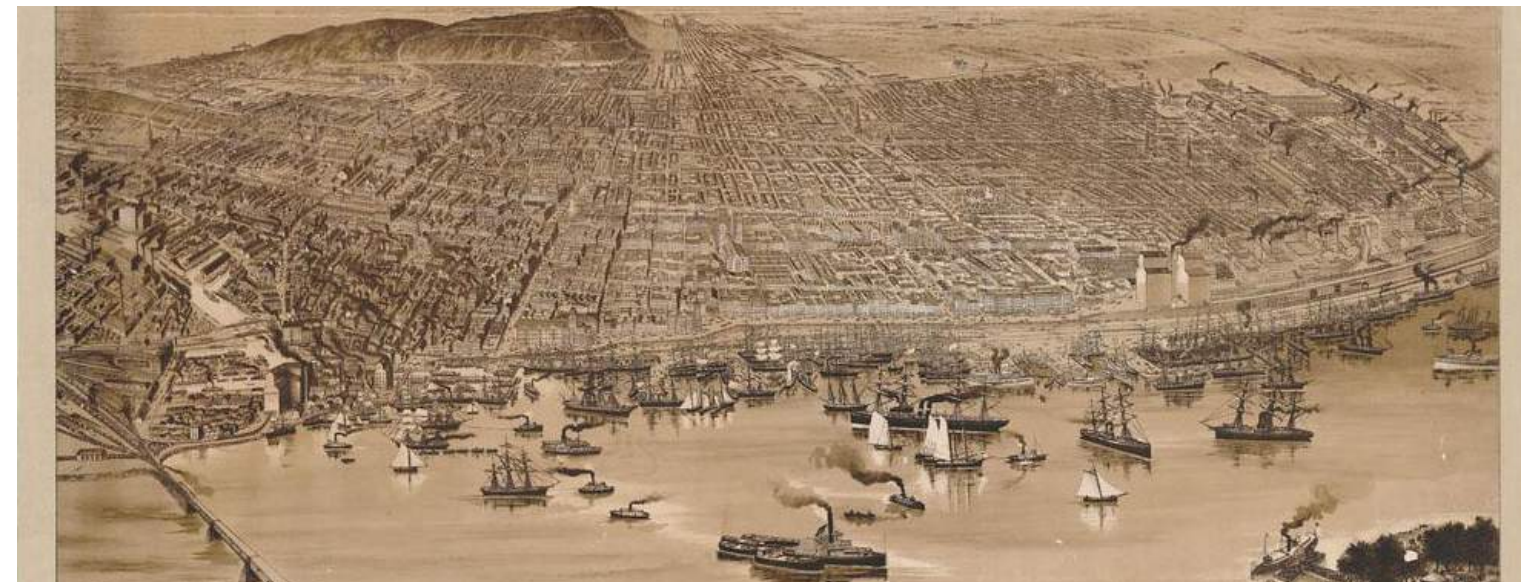
Représentation du port de Montréal avant la première digue, 1898, Bibliothèque et Archives Canada, C 066743.
