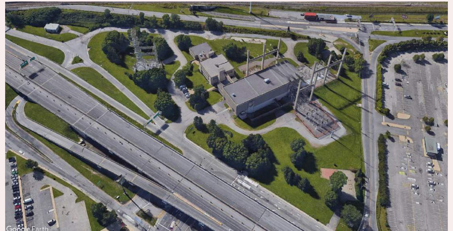
Vue axiale du poste de transformation électrique Viger à l'intersection des rues Bridge et des Irlandais, 2018, Google Street View.
