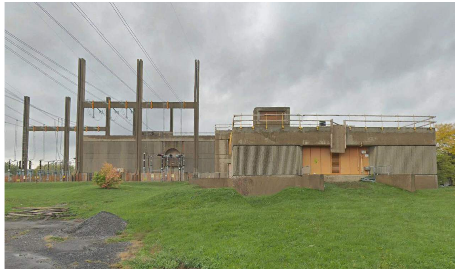
Poste de transformation électrique Viger, 2018, Google Street View.
