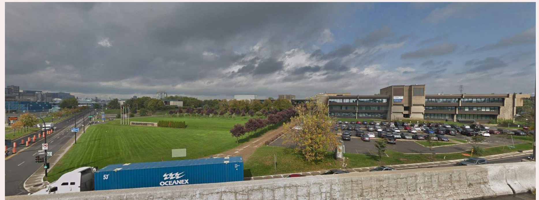
Vue sur l'unité paysagère à partir du tablier de l'autoroute Bonaventure, 2019, Google Street View.
