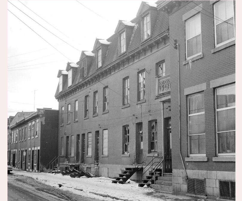
Victoriatown avant la démolition, 1963, Archives de la Ville de Montréal VM94-C312-013.
