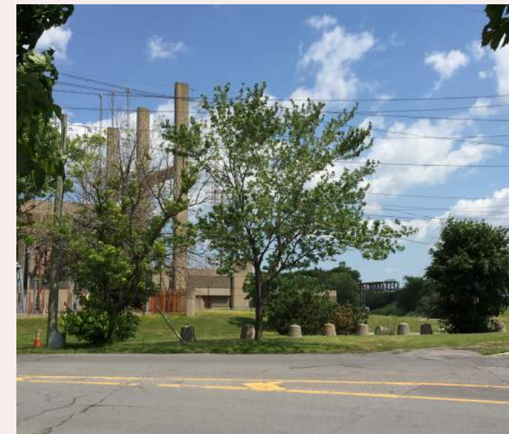
Rue des Irlandais et poste de transformation Viger au centre d'un terrain végétalisé, 2019, Jonathan Cha.
