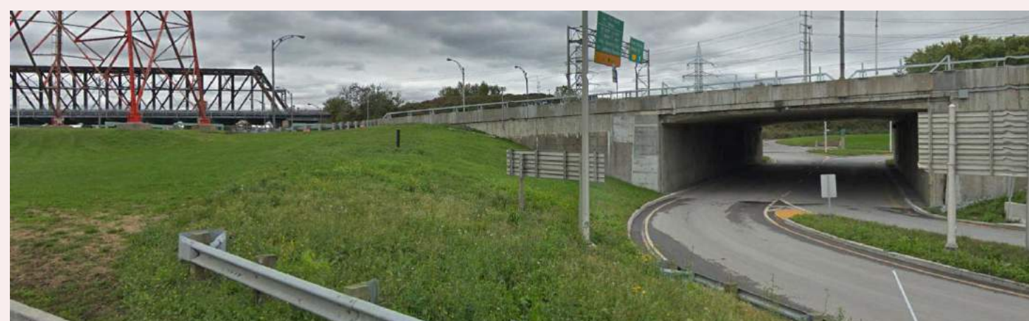
Début du soulèvement du tablier de l'autoroute Bonaventure qui est abaissée au niveau du pont Victoria, 2018, Google Street View.
