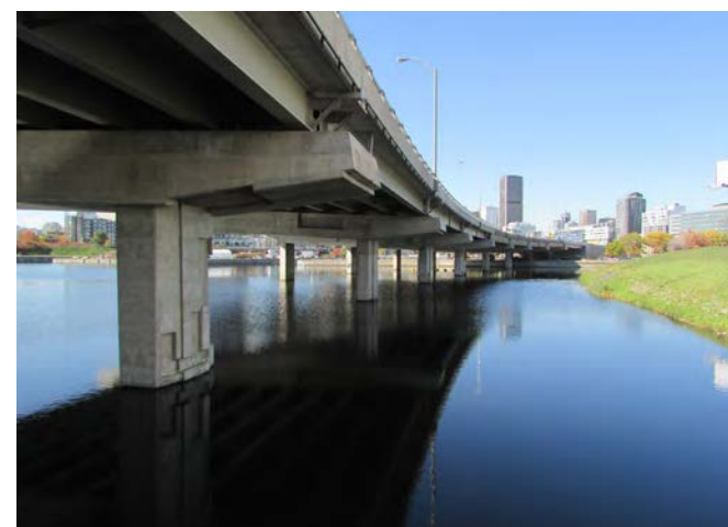
2. Vue depuis le déversoir vers l'ouest
