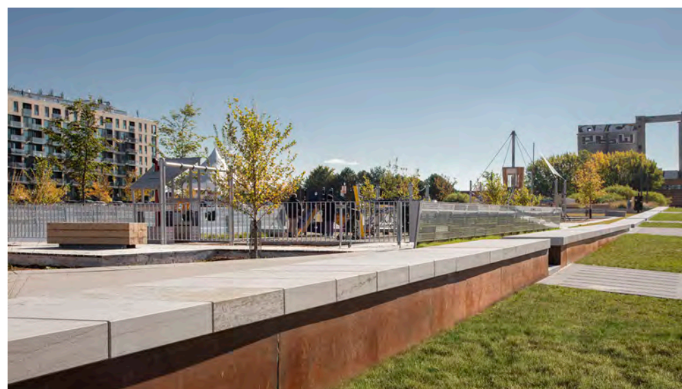
Mise en valeur du tracé du bassin à bois, parc du Bassin-à-Bois (Olivier Blouin)
