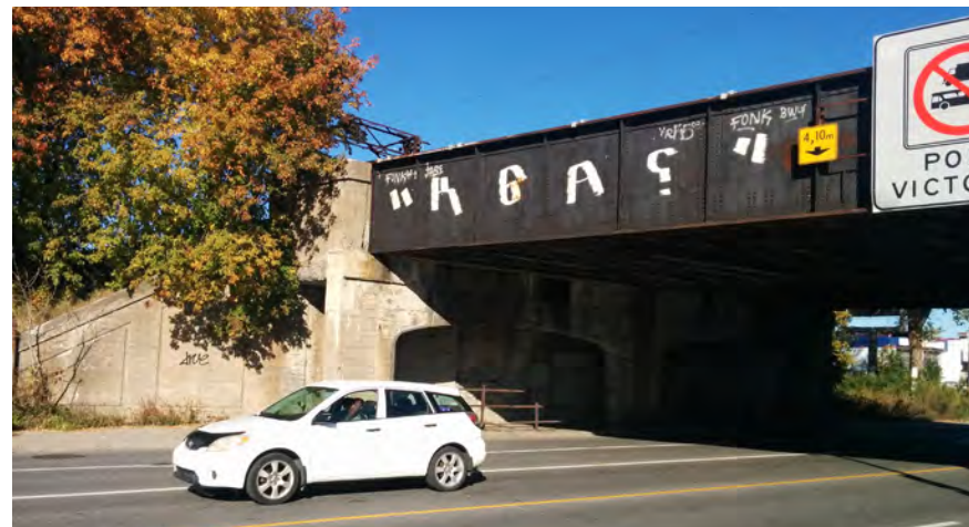
5. Viaduc ferroviaire enjambant la rue Bridge
