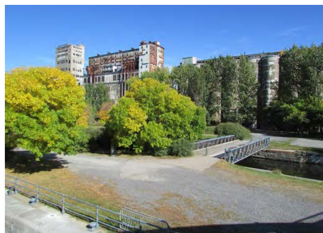
1. Vue vers le canal et les silos de la pointe depuis le pont de la rue Mill
