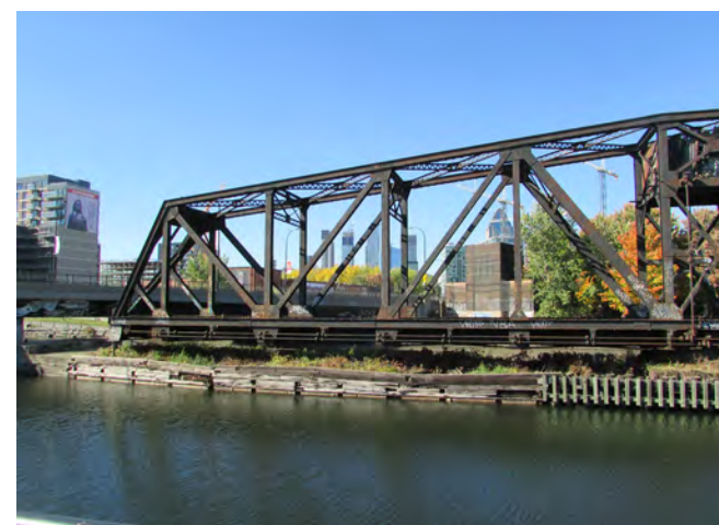
5. Moyens de franchissement du canal de Lachine
