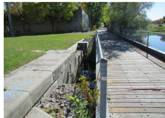
5. Ancien mur du canal et ancien pertuis
