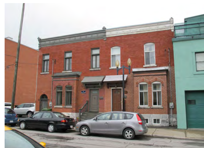
5. Alignement de résidences sur la rue De Condé
