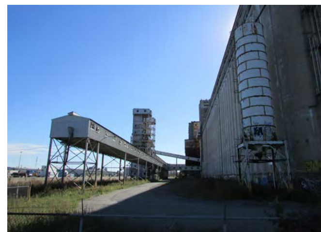
2. Vue vers les convoyeurs et les silos depuis le bout de la pointe
