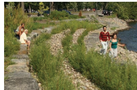
Stabilisation des berges
