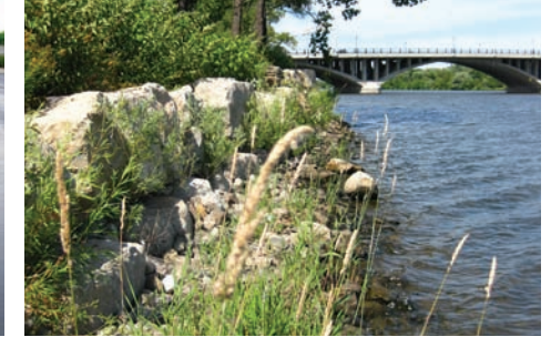
Stabilisation des berges
