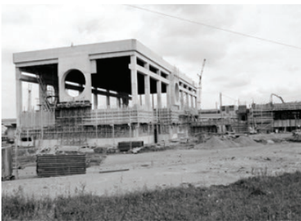
Construction du poste Viger, 1980 Source : Histoires d'Hydro-Québec-Le poste Viger, HydroPresse, 2016-02-29
