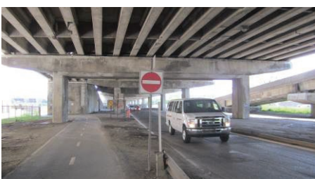
Piste cyclable sous l’autoroute Bonaventure
