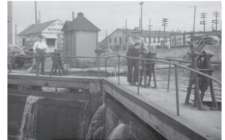
Mécanisme manuel d'ouverture des écluses, 1948, Conrad Poirier Source : BANQ
