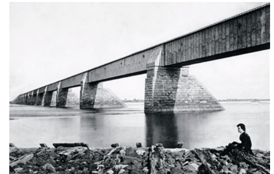
Pont tubulaire Victoria
