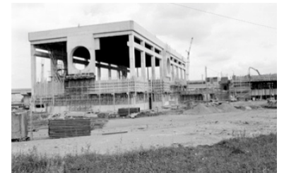
Construction du poste Viger
