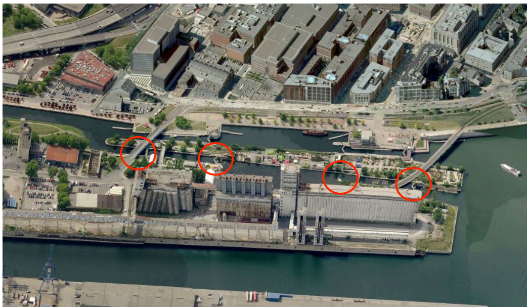
Emplacement des écluses 1 et 2 sud, 2017 (Bing Maps)
