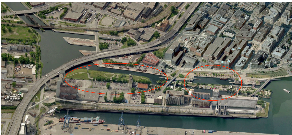
Emplacement des bassins 1 et 2, 2017 (Bing Maps)
