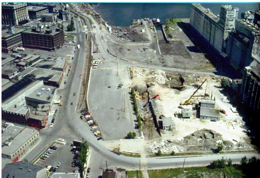
Travaux de déblaiement des écluses 1 et 2, nord et sud, 1984-1985 (Pauline Desjardins, Le Vieux-Port de Montréal , 2007, p. 192)
