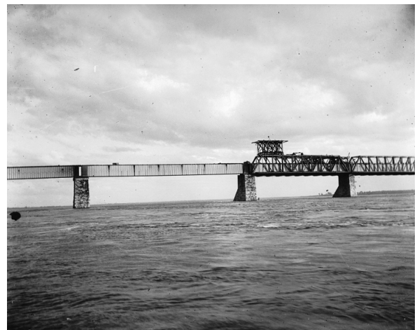
Remplacement de la structure tubulaire pour une structure à treillis, 1898 (Musée McCord)
