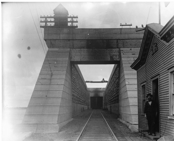
Entrée du pont tubulaire, 1896 (Musée McCord)
