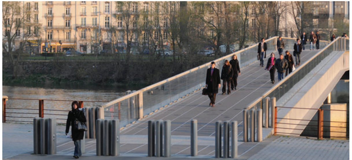
Nantes, Passerelle Schoelcher, Equipements, 2001 Photo : http://www.iledenantes.com/fr/projets/216-passerelle-schoelcher.html
