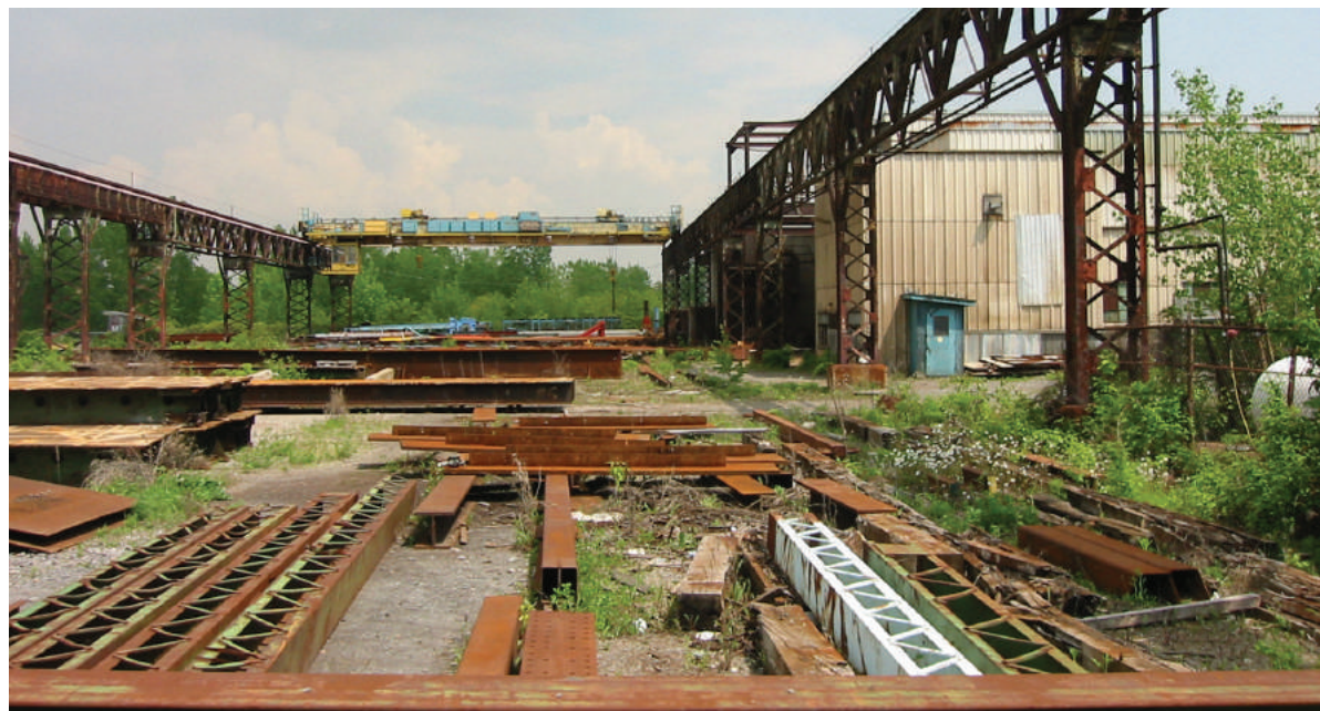
Ateliers de la Dominion Bridge Source : Kim Gallup, 2005
