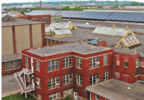
Ateliers de la Dominion Bridge Source : Kim Gallup, 2005
