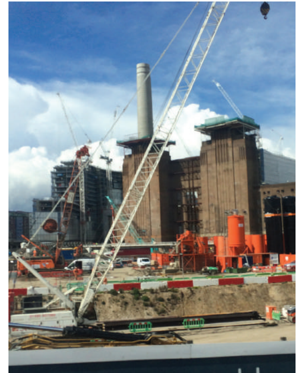
Londres, Réhabilitation de Battersea Power Station Photos : Kim Gallup, 2016
