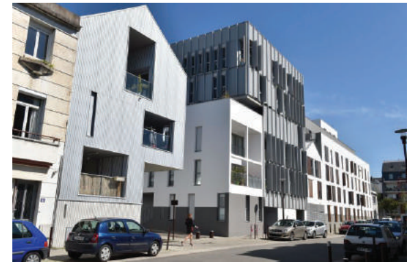
Nantes, Les Terrasses de L'île, logements, 2010-2012 Source : http://www.iledenantes.com/fr/projets/52-les-terrasses-de-l-ile.html
