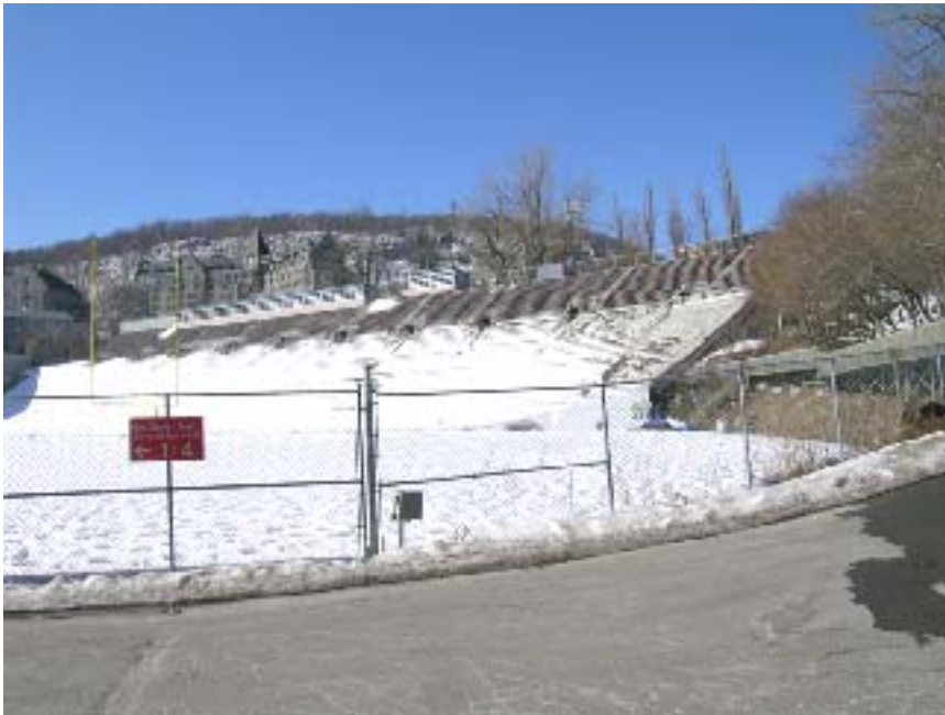
Les gradins nord existants (après phase 1)
