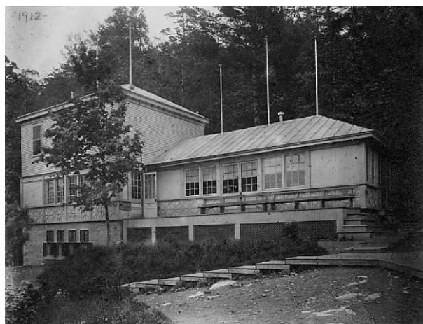
Figure 37- Kiosque comprenant un magasin, un restaurant, et le bureau du frère André (1912)
