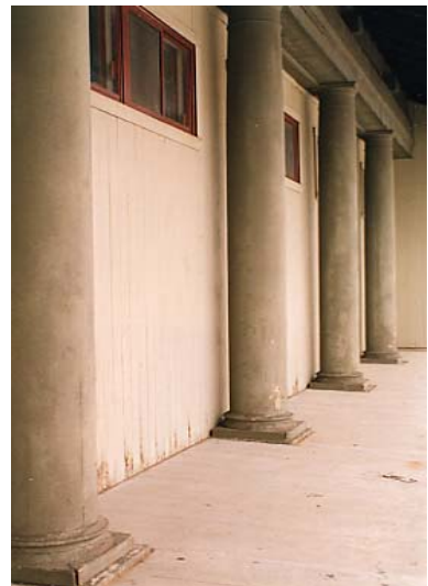
Figure 64 - Mur de l'auberge
