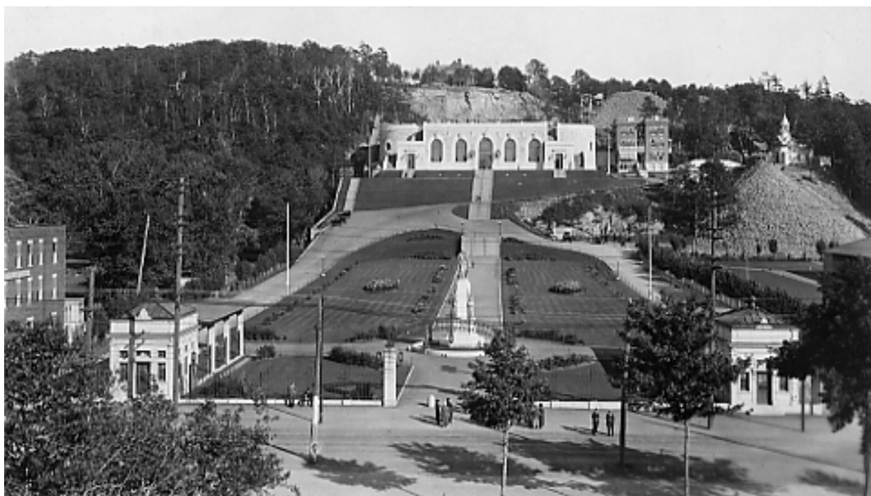
Figure 58 - Arche du portail d'entrée (1924)
