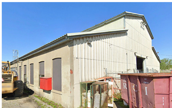
▲ Figure 102. Façades Sud et Est du bâtiment 4.
