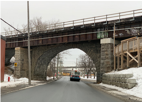
Figure 70. Le viaduc vu vers l'est.
