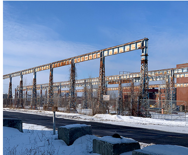
Figure 119. Les ponts roulants 1 et 2 à la Dominion Bridge .
