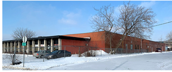
▲ Figure 88. Façades Est et Sud 130-140 boulevard Saint-Joseph. Les élévations latérales et arrière comptent très peu d'ouvertures mises à part celles destinées au chargement-déchargement.
