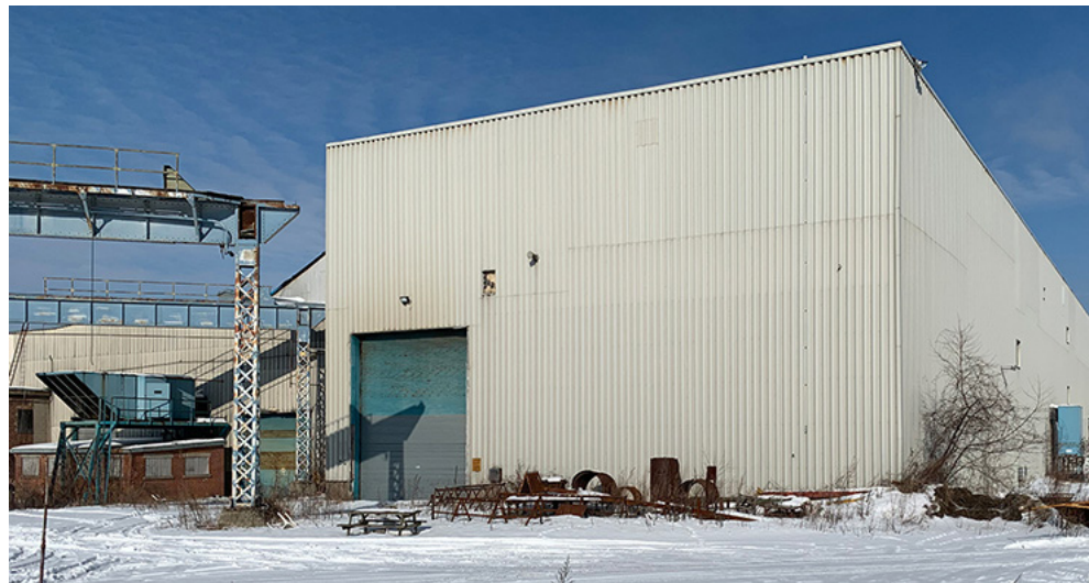
▲ Figure 81. L'atelier de charpente de la Dominion Bridge est aussi une grande halle en brique complètement recouverte de tôle. Elle est construite avant 1912 puisqu'elle apparaît sur le plan des assureurs Goad de 1912.
