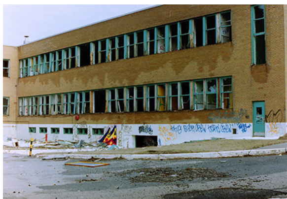
▲ Figure 53. Bâtiment administratif de la Jenkins en 1996.
