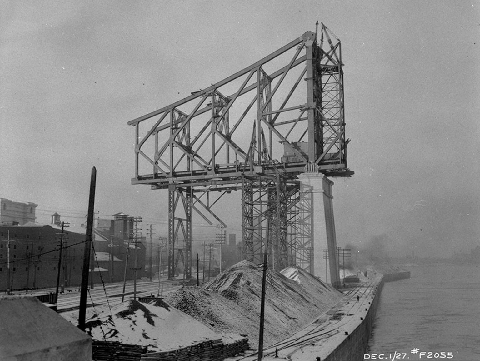
▲ Figure 43. Construction du pont du Havre (Jacques-Cartier).
