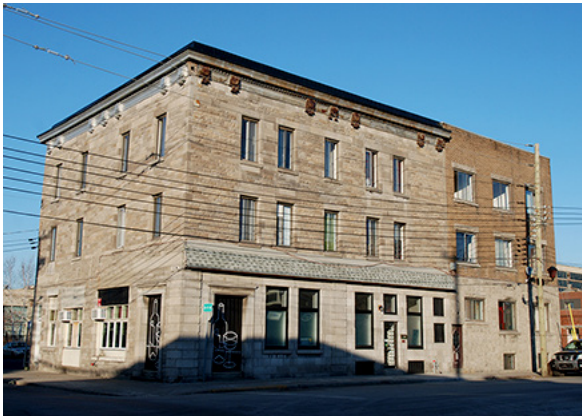
Figure 67. L'ancien hôtel King-George, qui logeait entre autres un bar surnommé le Snake Pit . Construit en 1912, sa hauteur et sa silhouette en pierre grise en font un élément signal dans l'environnement.
