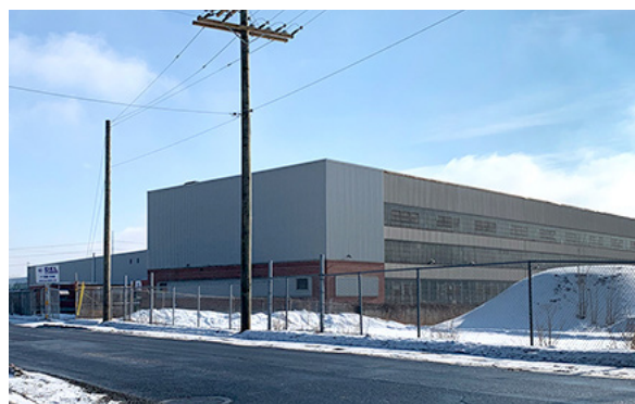
▲ Figure 105. La façade Nord de l'atelier (1) de cette grande halle de plan rectangulaire aujourd'hui revêtue de tôle ondulée, était dotée à sa construction de bandeaux vitrés similaires à ceux de la façade ouest.
