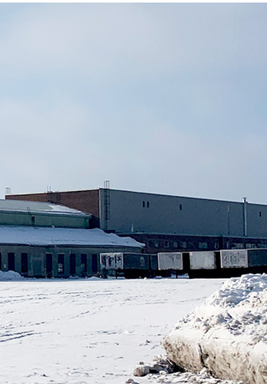
▲ Figure 81. L'atelier de charpente de la Dominion Bridge est aussi une grande halle en brique complètement recouverte de tôle. Elle est construite avant 1912 puisqu'elle apparaît sur le plan des assureurs Goad de 1912.
