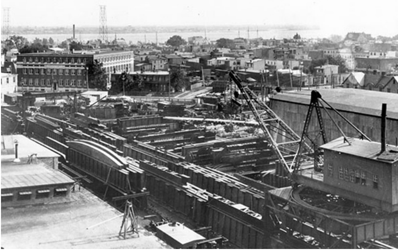
Figure 116. Une grue pivotante à la Dominion Bridge . Non daté.
