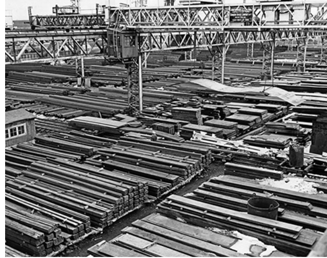
Figure 117. Utilisation d'un pont roulant à la Dominion Bridge pour de l'entreposage d'acier de charpente. Non daté.
