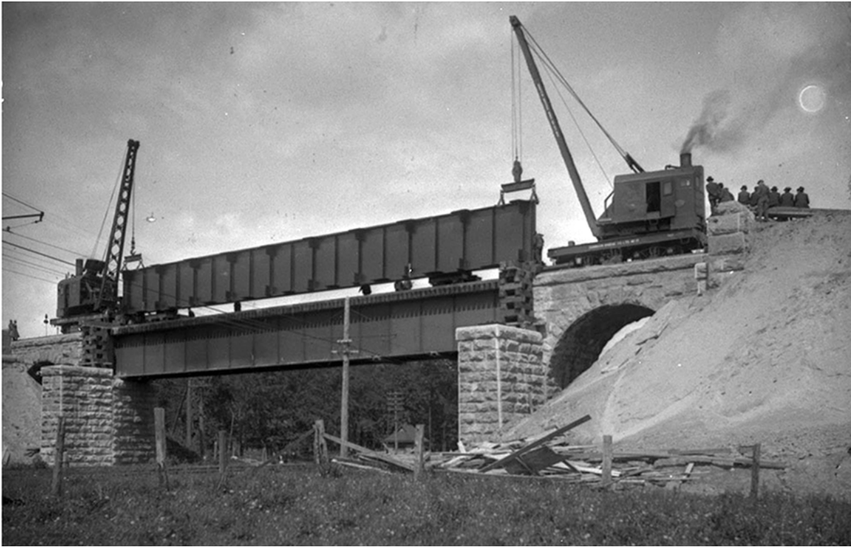
Figure 69. Le viaduc Rockfield en cours d'élargissement le 12 mai 1912.
