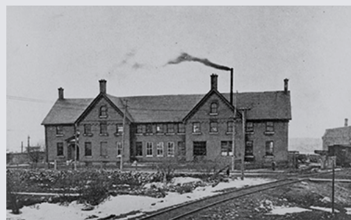
▲ Figure 32. Façade principale du premier édifice administratif.
