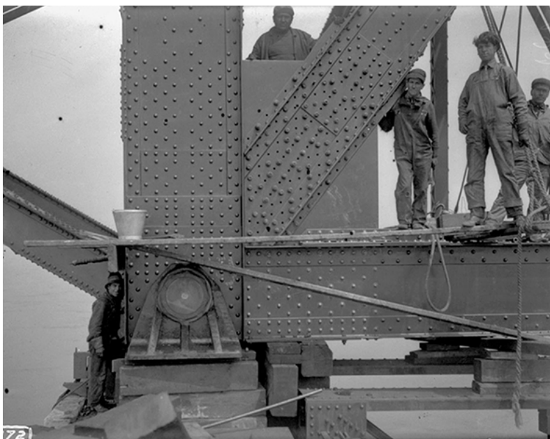
Figure 135. Travaux entrepris pour consolider et aménager une deuxième voie ferrée pour le pont Saint-Laurent et terminés en novembre 1913.
