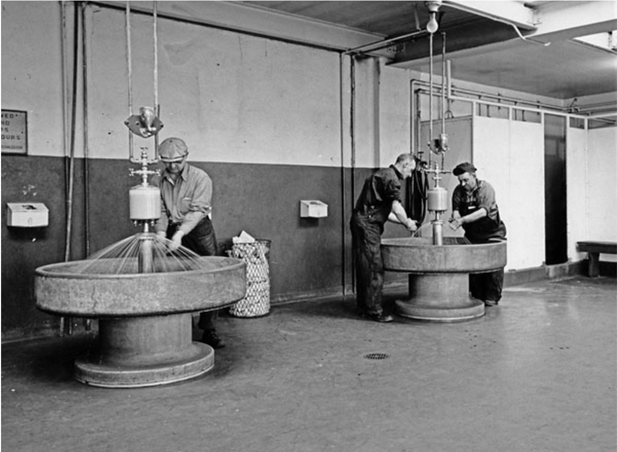
▲ Figure 132. Les installations dans l'aire des douches.
