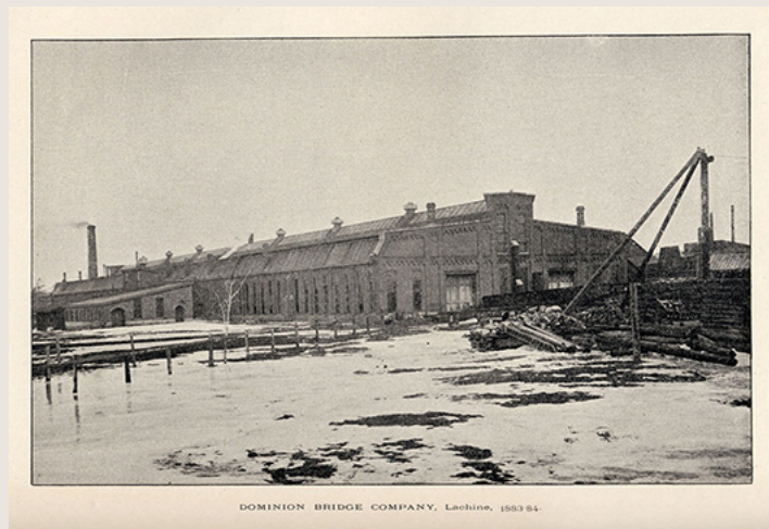
Figure 110. Parties des installations de la Dominion Bridge en 1883-84.
