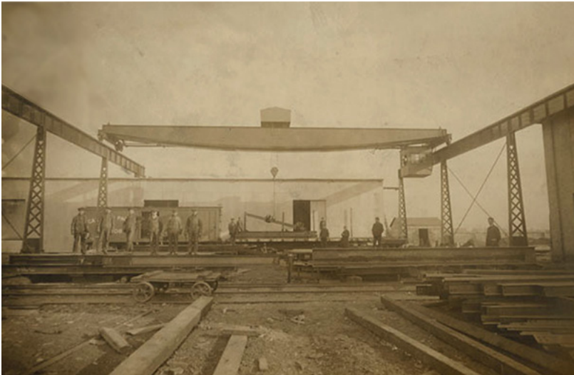
Figure 118. Le pont roulant de la cour d'expédition à la Dominion Bridge . Non daté.
