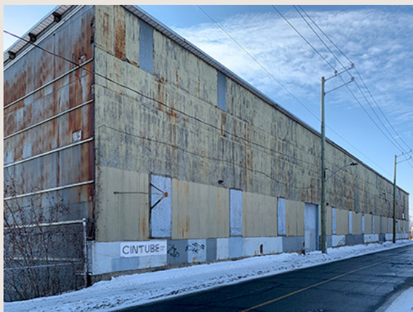
▲ Figure 78. Atelier des services de la construction de la Cintube ( Dominion Bridge Sud ) (101), une grande halle en brique recouverte de différents types de tôle.
