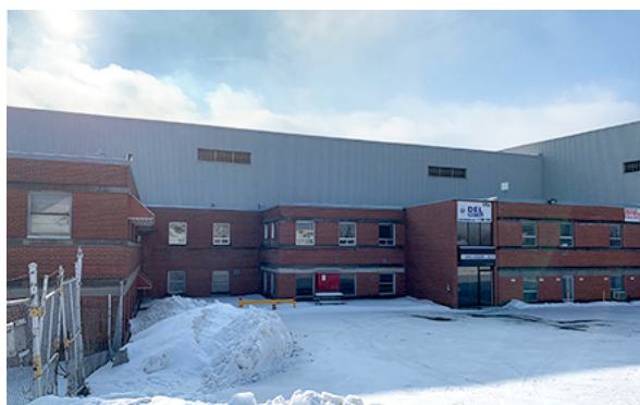
▲ Figure 104. Vue sur les bureaux (5) dont l'horizontalité se manifeste avec l'insertion des bandeaux de béton et l'atelier de construction (2) en arrière-plan qui était doté de deux grandes bandes continues vitrées pratiquement complètement obstruées aujourd'hui par le revêtement métallique.
