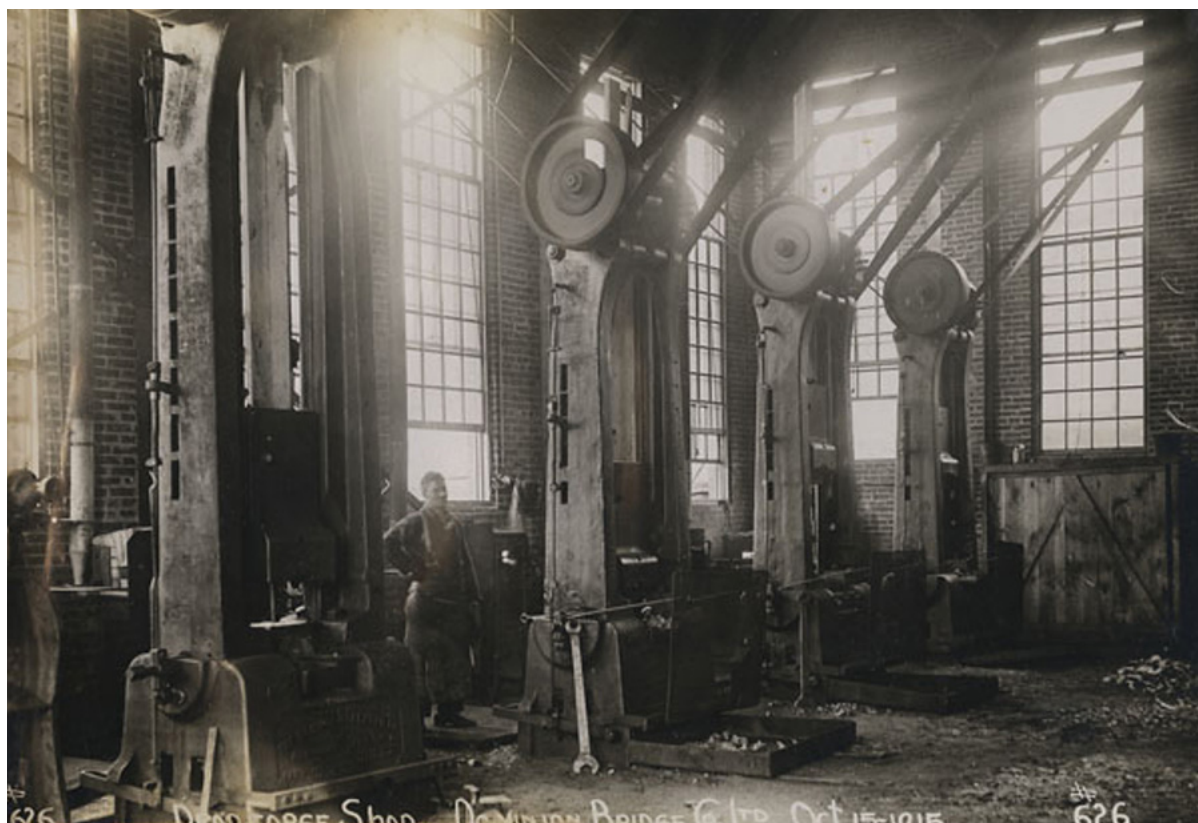
Figure 131. L'atelier des forges de la Dominion Bridge le 15 octobre 1915.
