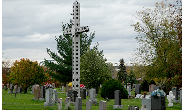
▲ Figure 138. La croix du cimetière VEAKATERI à Kahnawake réalisée en pièces métalliques boulonnées et rivetées.
