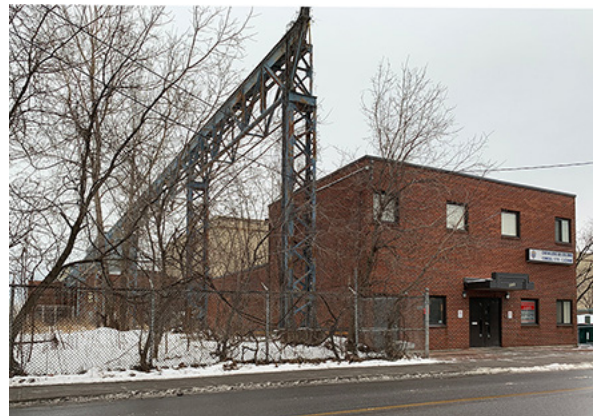
Figure 68. L'immeuble des Chevaliers de Colomb au 280, 6 e Avenue.
