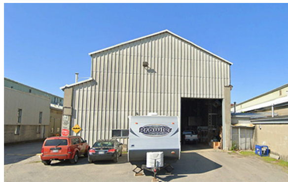
▲ Figure 103. Façade Est du bâtiment 6.
