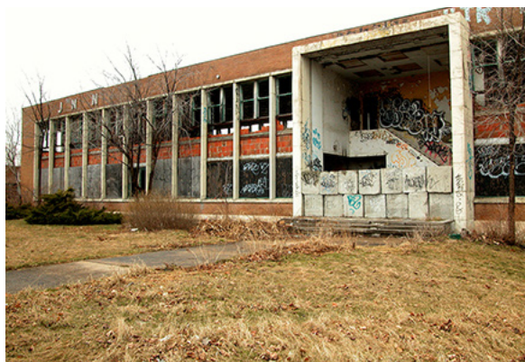
▲ Figure 54. Bâtiment administratif de la Jenkins en 2004.
