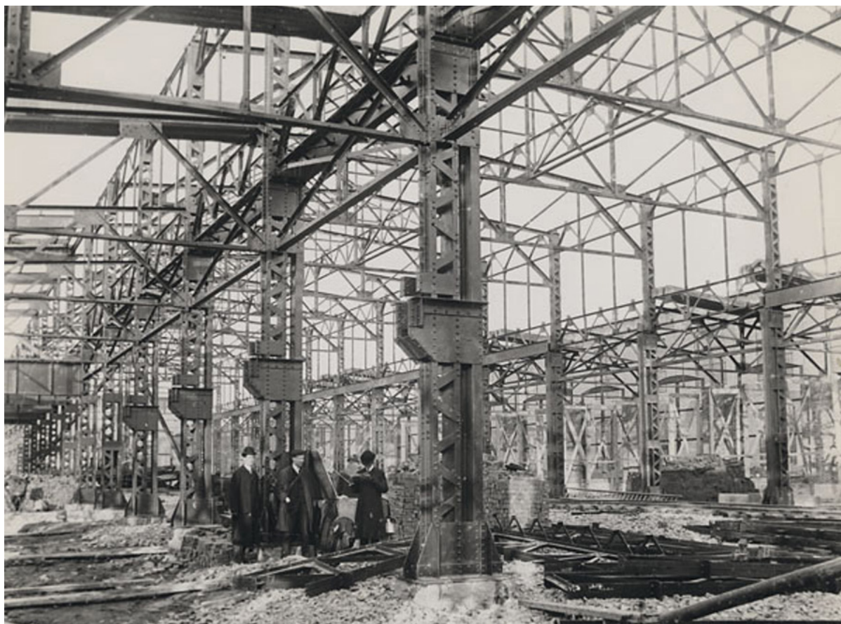
Figure 111. Montage de la structure d'acier de l'atelier de charpente qui offre une grande flexibilité d'aménagement, d'agrandissement, d'éclairage naturel, etc. vers 1915.
