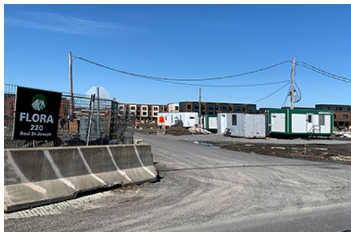
▲ Figure 90. Vue sur le complexe résidentiel en construction à l'intersection du boulevard Saint-Joseph.
