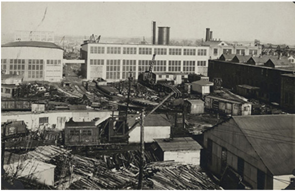
▲ Figure 40. Vue des installations de la Dominion Bridge vers 1915. Deux modes de construction se côtoient. À droite, une bâtisse en maçonnerie de briques avec des lanterneaux et, au centre, deux bâtiments sont à charpente d'acier revêtue de tôle et sont très largement fenêtrés.
