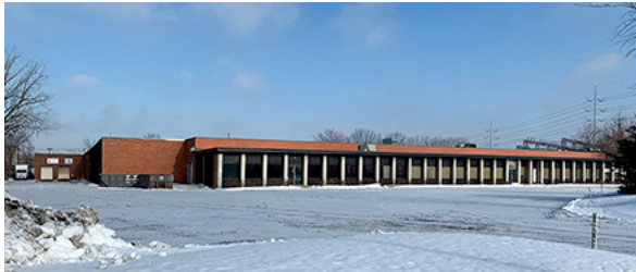
▲ Figure 87. Façade Sud du bâtiment 130-140 boulevard Saint-Joseph. La partie avant qui est occupée par des bureaux, présente une façade rythmée par d'imposants pilastres de béton préfabriqué de couleur pâle.
