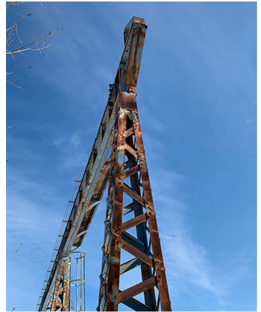
▲ Figure 64. Vestiges des ponts roulants du secteur nord de la Dominion Bridge .
