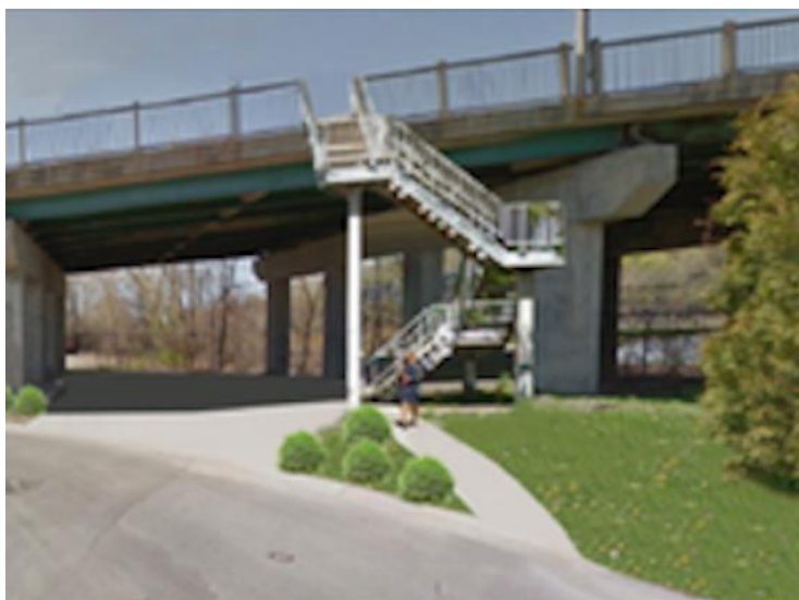
Figure 6-8: Aménagement des marches d'escalier pour piétons
