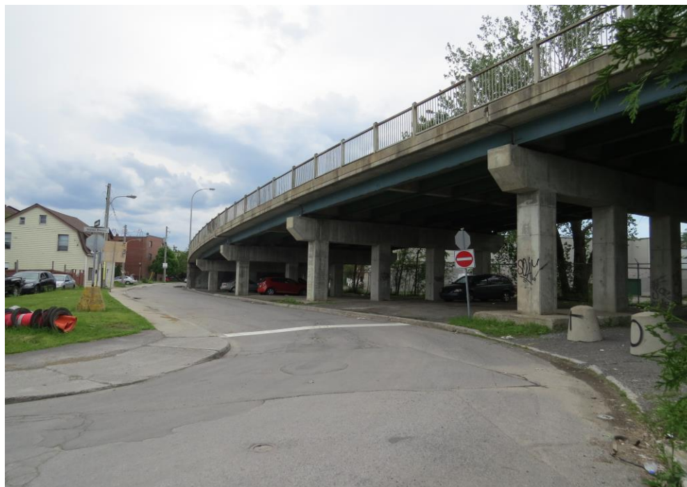
Figure 6-7: Vue de dessous du viaduc Saint-Jacques
