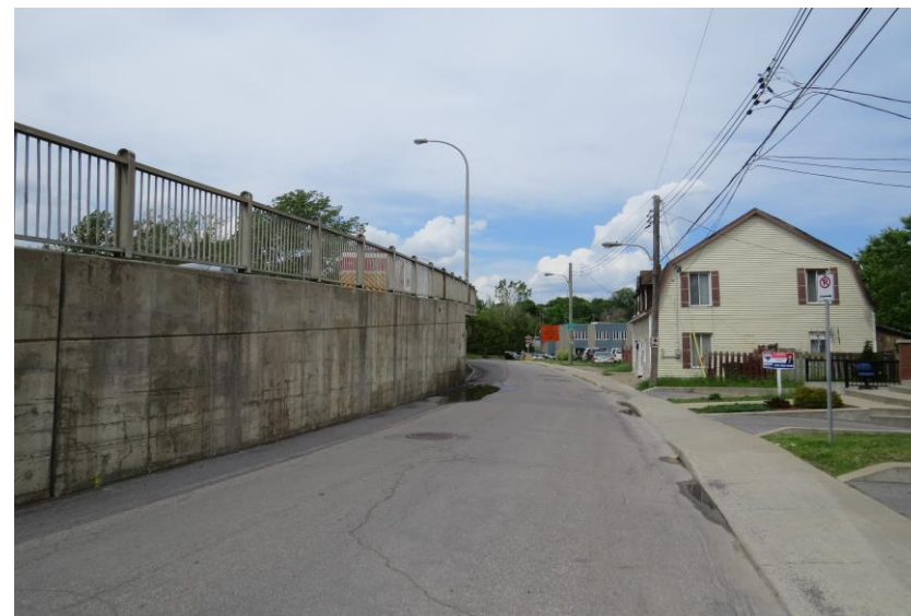
Figure 6-9 : Structure est du viaduc Saint-Jacques
