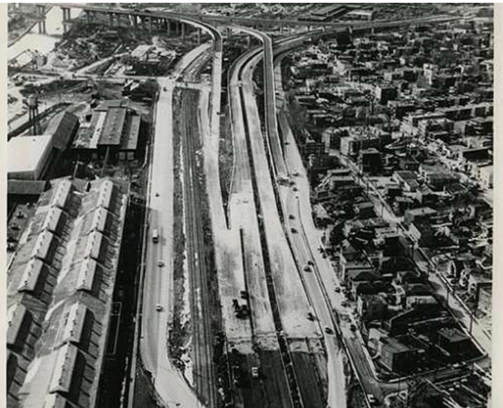
Construction Echangeur Saint-Pierre, source : www.transports.gouv.qc.ca
