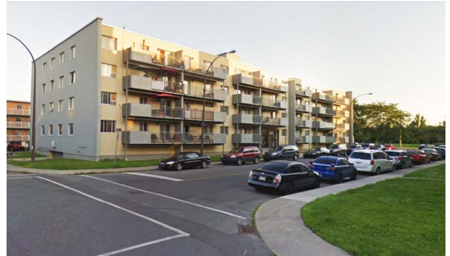
Habitations à loyer modique sur la rue Duff Court
