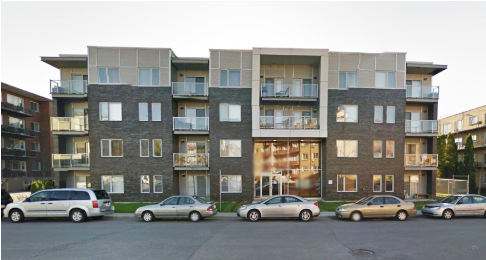
Logements gérés par l'organisme « Logements communautaires LaSalle » près de la 32e avenue
