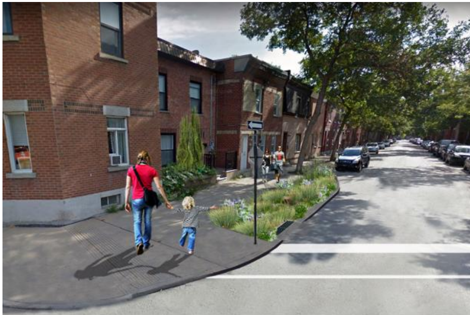
Saillies de trottoir drainantes, projet dans l'arrondissement du Sud-Ouest (Grenier, 2019)
