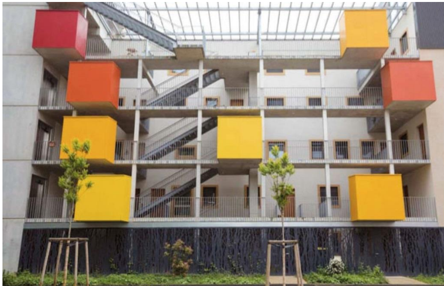
Immeuble K'Hutte, espaces de rangement dédiés à chaque logement Photo : Jérôme Dorkel
