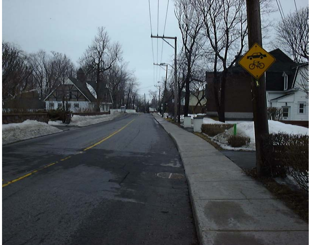
Figure 90 La mixité de modes de transport sur les voies publiques est à encourager. (Boulevard Bord-du-Lac.)
