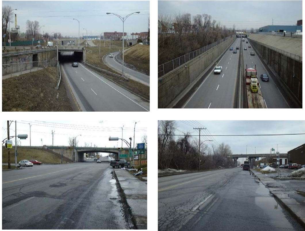
Figure 49 : L'entrée en ville à partir du pont Mercier: rampes de sortie, autoroute en tranchée, viaduc par-dessus la rue Clément, viaduc par-dessus la rue Saint-Patrick et le canal de Lachine.
