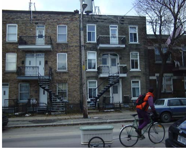
Figure 62: Triplex typiques des parties urbaines de Verdun. (Avenue Willibrod.)
