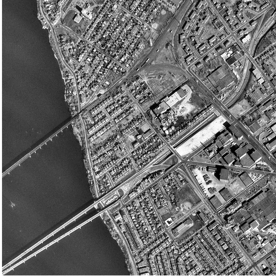
Figure 47 : Détail de l'entrée par l'autoroute 138 à Lasalle.
