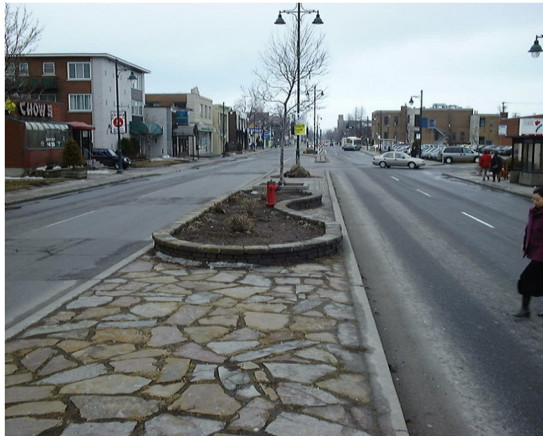
Figure 86 Rond-point Dorval. En haut, le site vu de l'est; la gare Dorval est à droite, l'autoroute 20 est au centre. Au milieu, l'avenue Dorval vue vers le nord; le talus au fond est le viaduc de l'autoroute au-dessus du rond-point. La troisième photo illustre l'avenue qui a des caractéristiques d'une rue commerciale urbaine.
