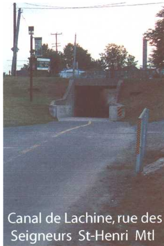
Tunnel de la rue des Seigneurs St-Henri Mtl
